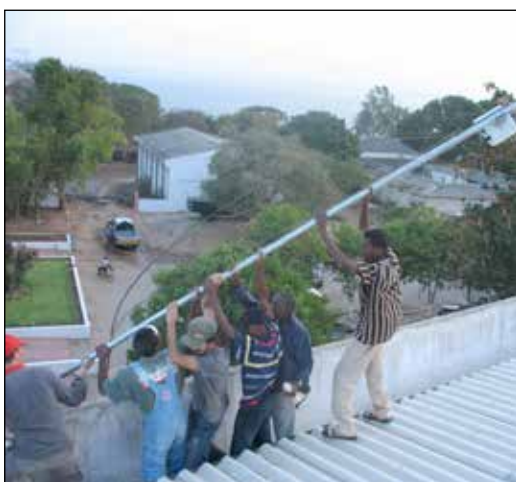
Figura 2. Instalación de mástiles.
