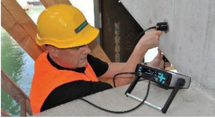
Figura 100. Trabajador realizando ensayo por ultrasonidos
