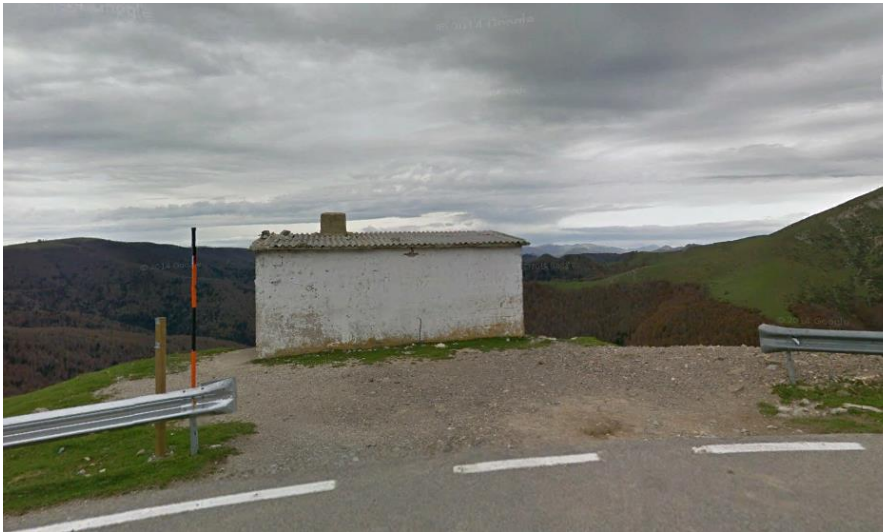
Figura 4.52: Lugar donde se instalará definitivamente la nueva Estación de Abodi [15]
