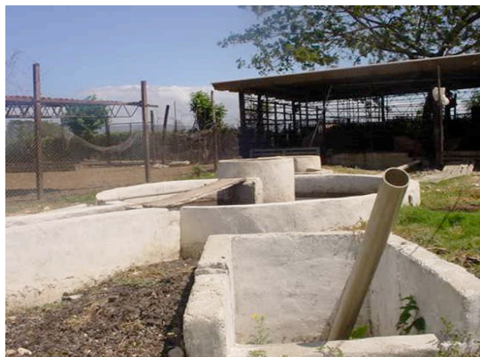
Figura 6.5: Biodigestor de tipo Chino
