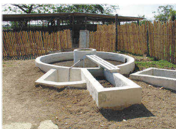
Figura 3.4: Biodigestor de cúpula fija en Guantánamo (Cuba)
