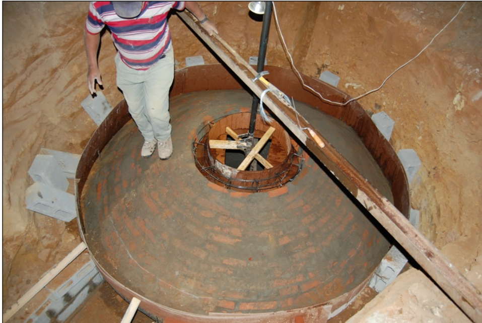
Figura 10.1: Biodigestor de cúpula fija en proceso de construcción
