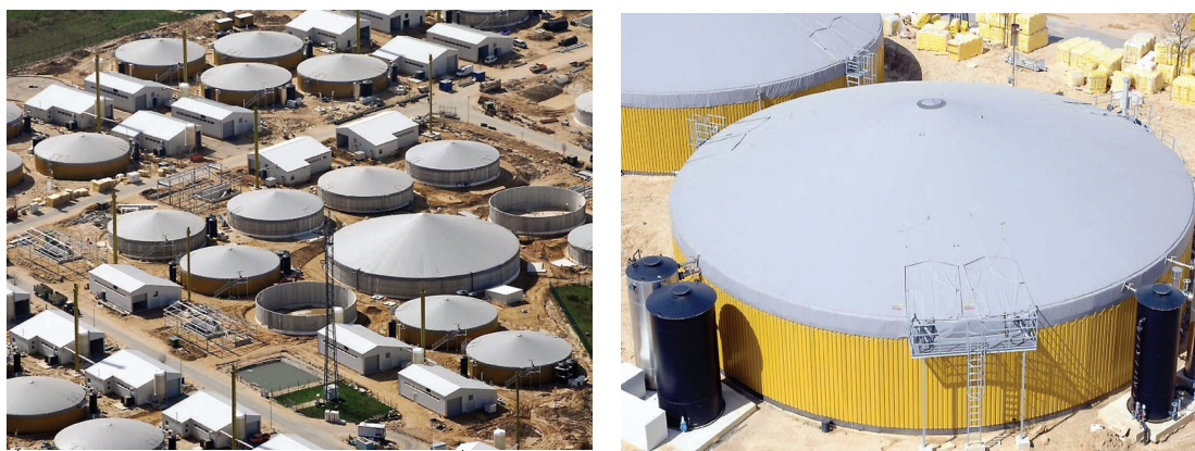
Figura 3.2: Planta de biogás de 20 MW en Mecklenburg-Vorpommern (Alemania)
