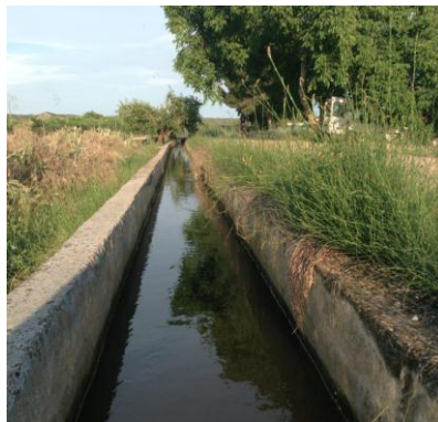
Acequia de agua de regadío del Canal de Lodosa en la Parcela 1
