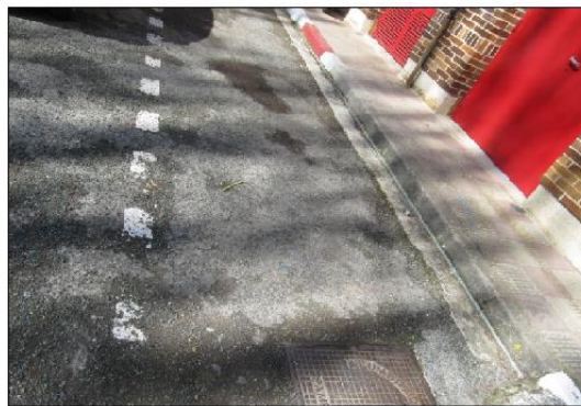
Figura 21: Asfalto y acera de la carretera de entrada
