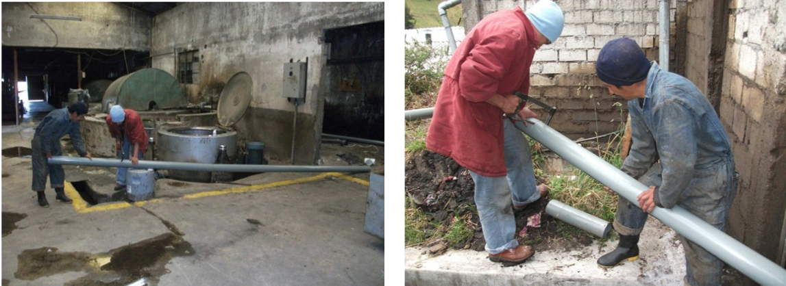
Fig. 8. Montaje de tuberías
