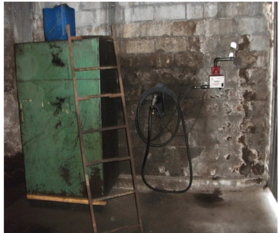
Tanque de diesel
