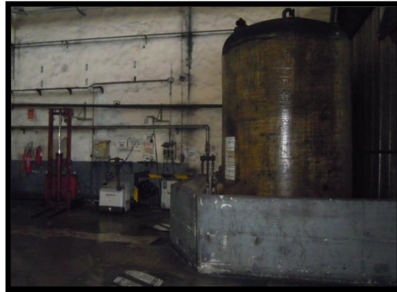
Ilustración 3.1.34: Depósitos de aceite y recarga de baterías
