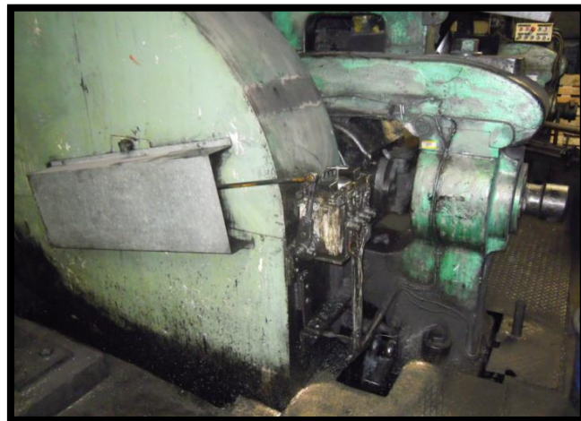
Ilustración 3.1.37: Puesto de control deteriorado
