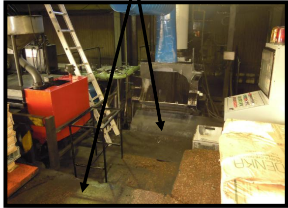
Ilustración 3.1.66: Boca del bambury limpia y pintada
