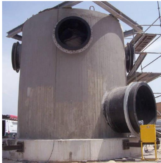
Torre de toma (ANEXO III, Figura 2)
