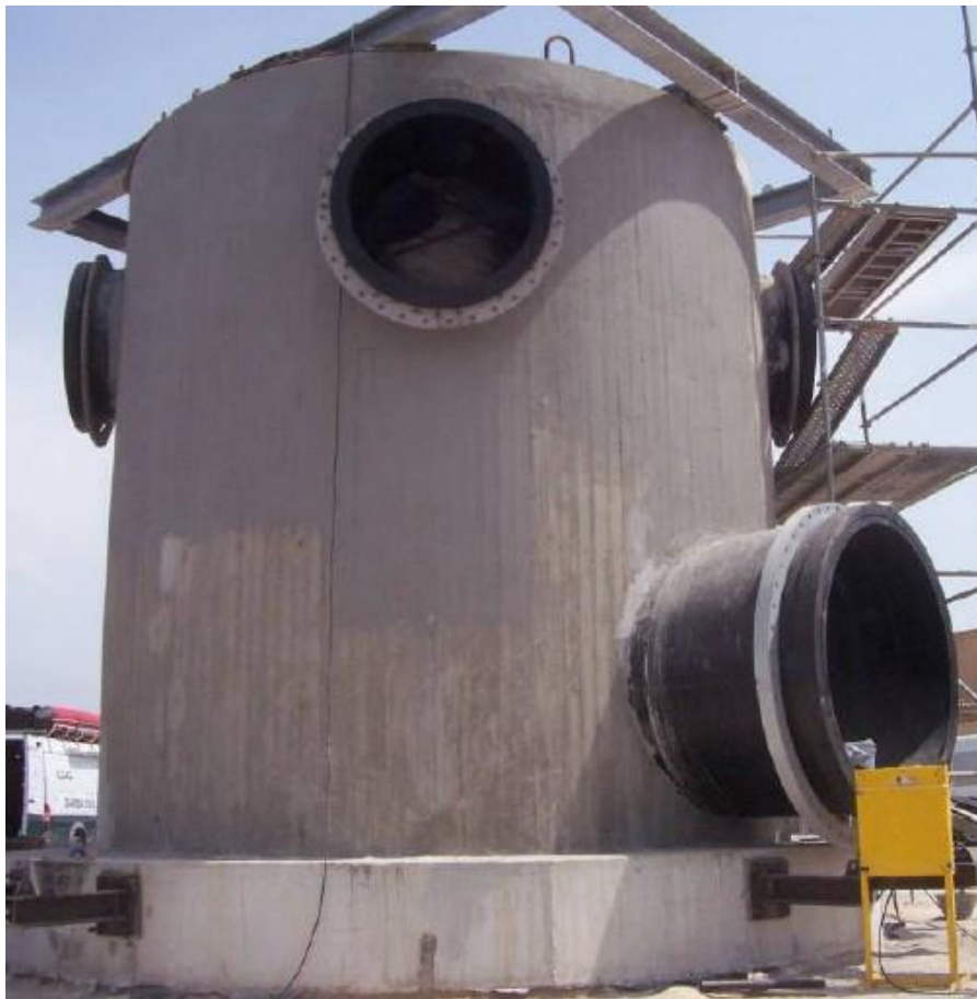
Figura 2: Torre de toma
