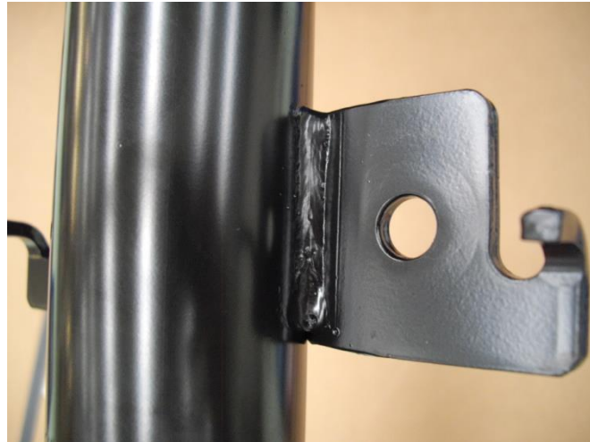
Fig. 66: Detalle de los cordones de la BAD
