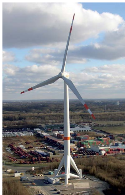
Figura 10: Prototipo de subestructura de tipo trípode [12].
