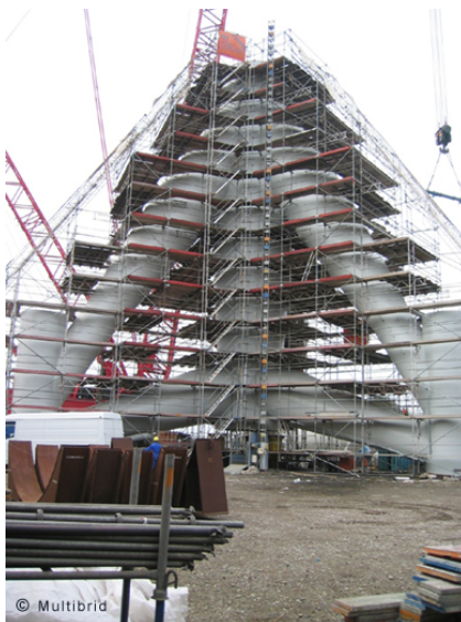
Figura 11: Subestructura trípode en construcción [12].
