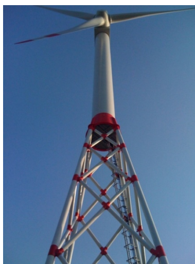
Figura 8: Subestructura de celosía [12].
