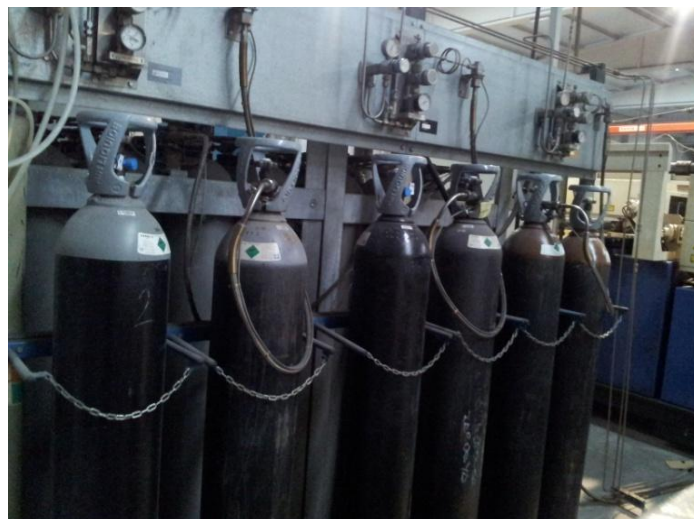
Figura 4: Bombonas compuestas por helio, CO 2 y nitrógeno
