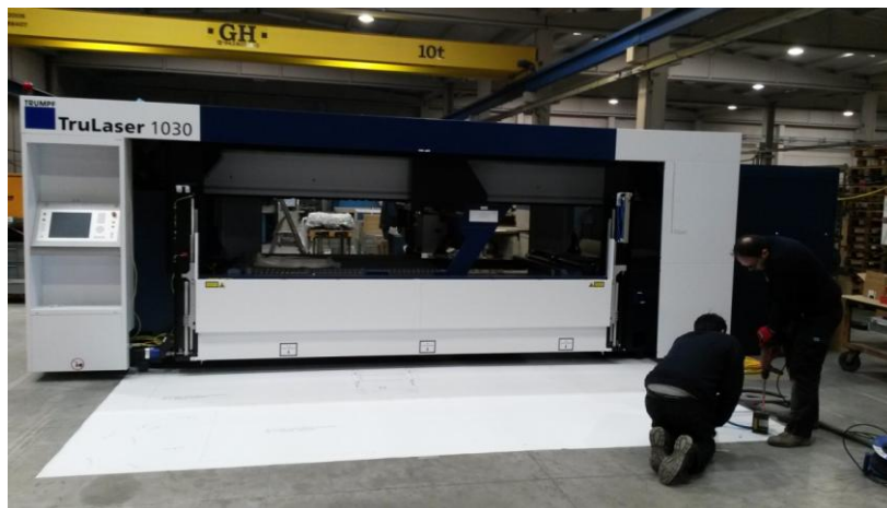
Figura 8: Operarios taladrando el suelo
