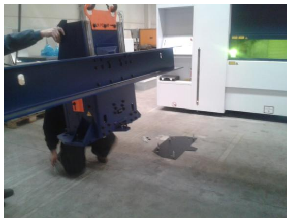
Figura 9: Operarios colocando las vigas-soporte
