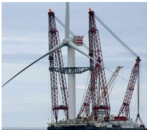
1.2. Fig. Offshore aerosorgailu baten instalazioa
