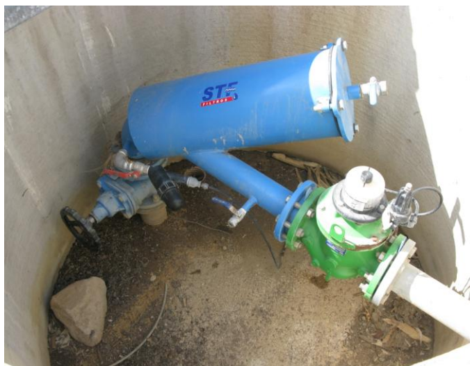
Figura 2.8. Elementos de un hidrante.
