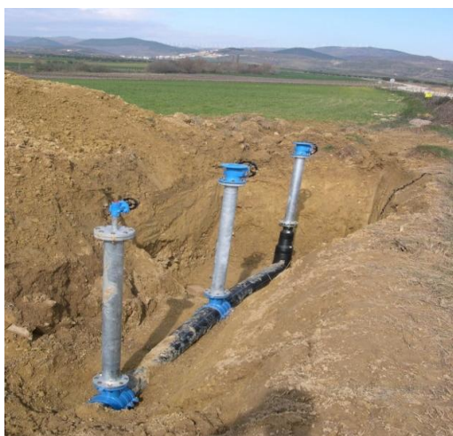
Figura 2.22. Acometidas de hidrante 21 y ventosa.
