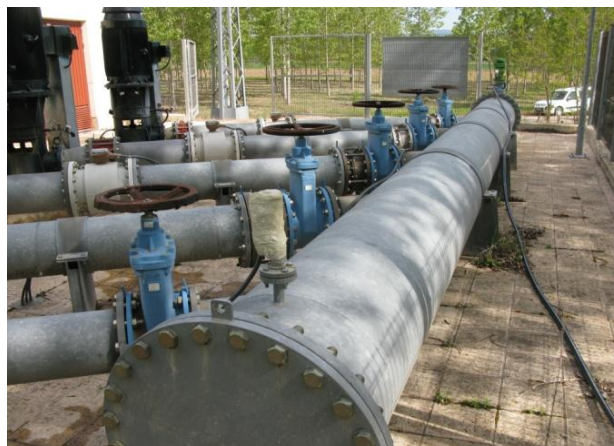
Figura 2.2. Colector general de impulsión.
