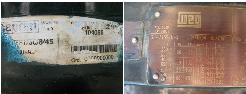
Figura 2.14. Placas de características de bomba y motor n° 1.
