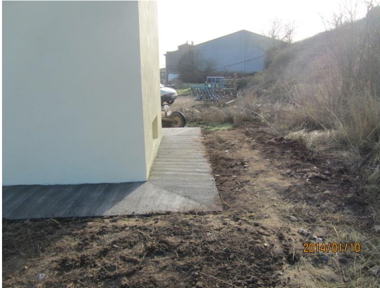
Acera perimetral CT
