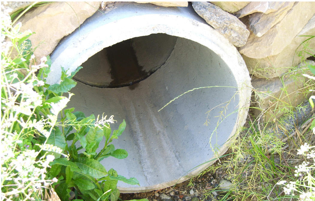
Imagen 2. Caño: desagüe de Tramo 1. Diámetro = 600 mm.
