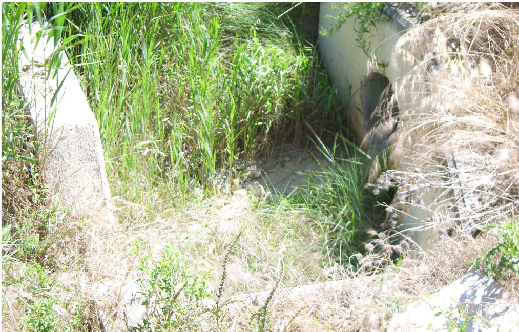
Imagen 6: Pocillo-Caño: desagüe tramo 3. Diámetro = 800 mm
