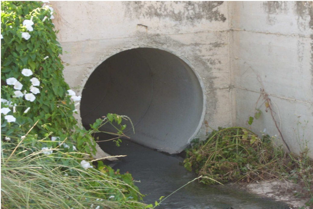
Imagen 4: Caño: desagüe tramo 2. Diámetro = 800 mm
