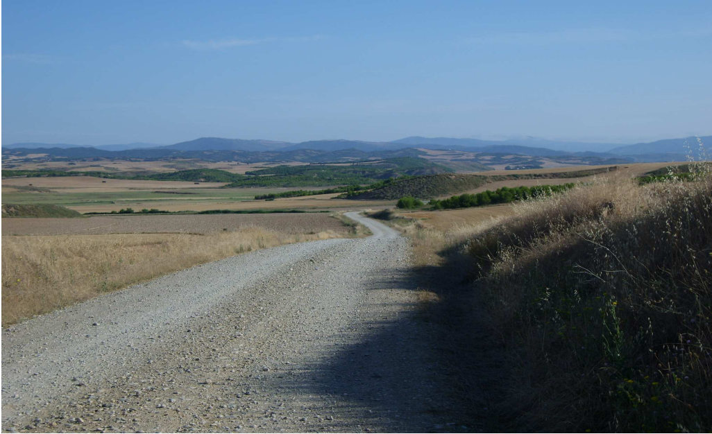
Imagen 3. Vista del camino y Cuneta: Tramo 2
