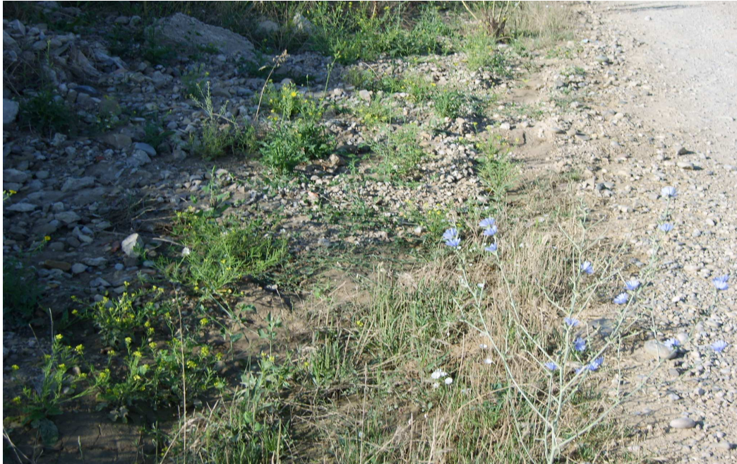
Imagen7. Tramo de cuneta completamente obstruido por gravas y tierra
