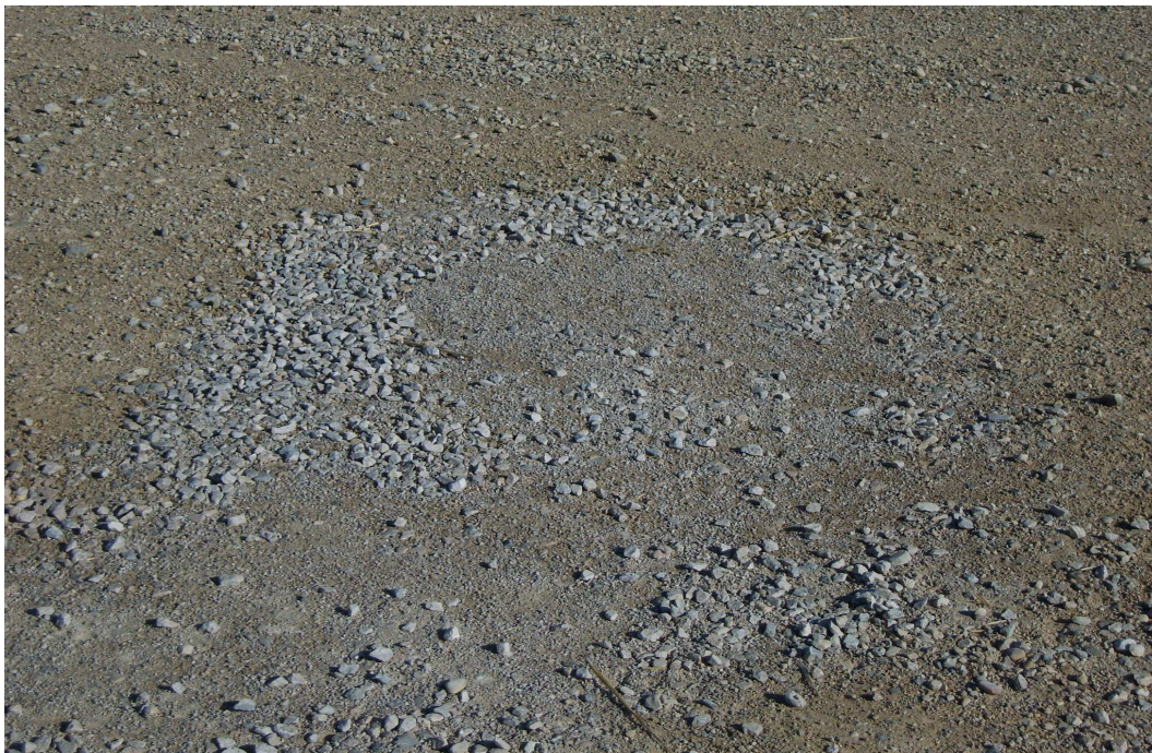
Imagen 8. Bache en la calzada reparado recientemente
