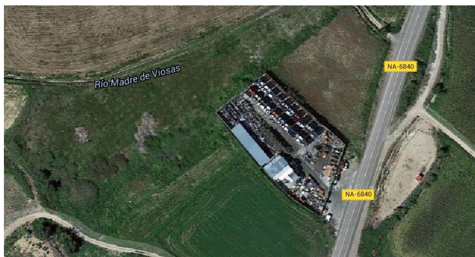
Imagen 3: Situación del almacén exterior.
