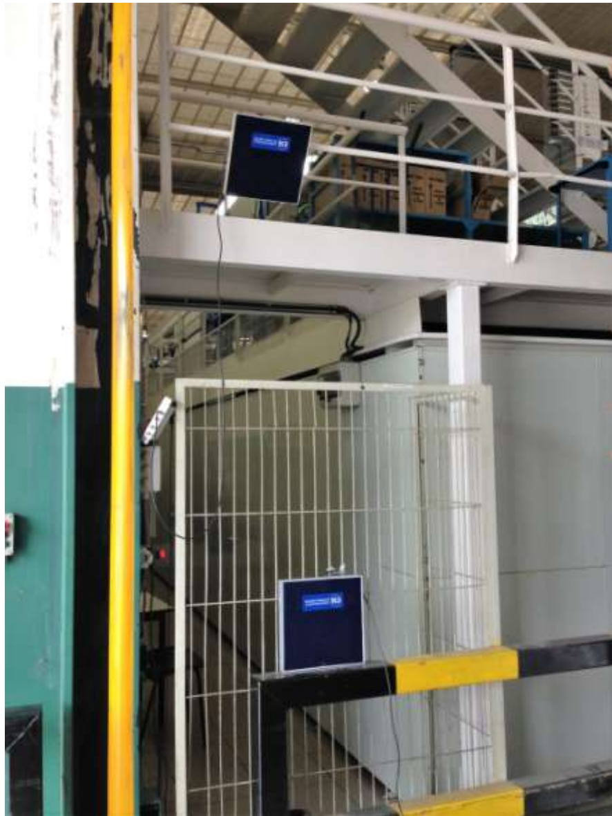
Ilustración 9. Colocación de las antenas en varias alturas
