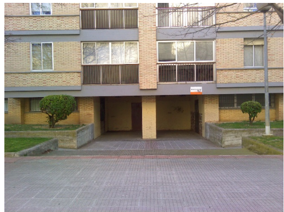
Figura 06: Estado actual. Fachada oeste: acceso a locales.
