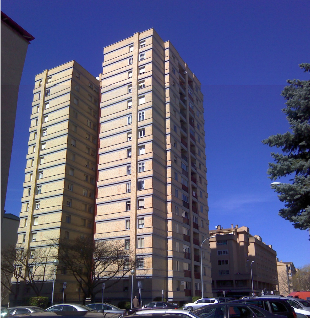
Figura 04: Estado actual. Fachada oeste: terrazas y miradores.
