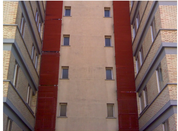
Figura 24. Fotografía. Fachada viviendas.
