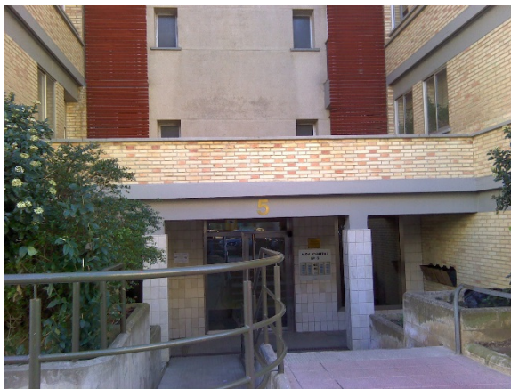
Figura 05: Estado actual. Fachada norte: portal.
