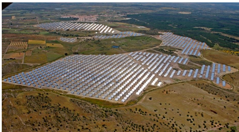
Figura 2.1 Central fotovoltaica de Amareleja
