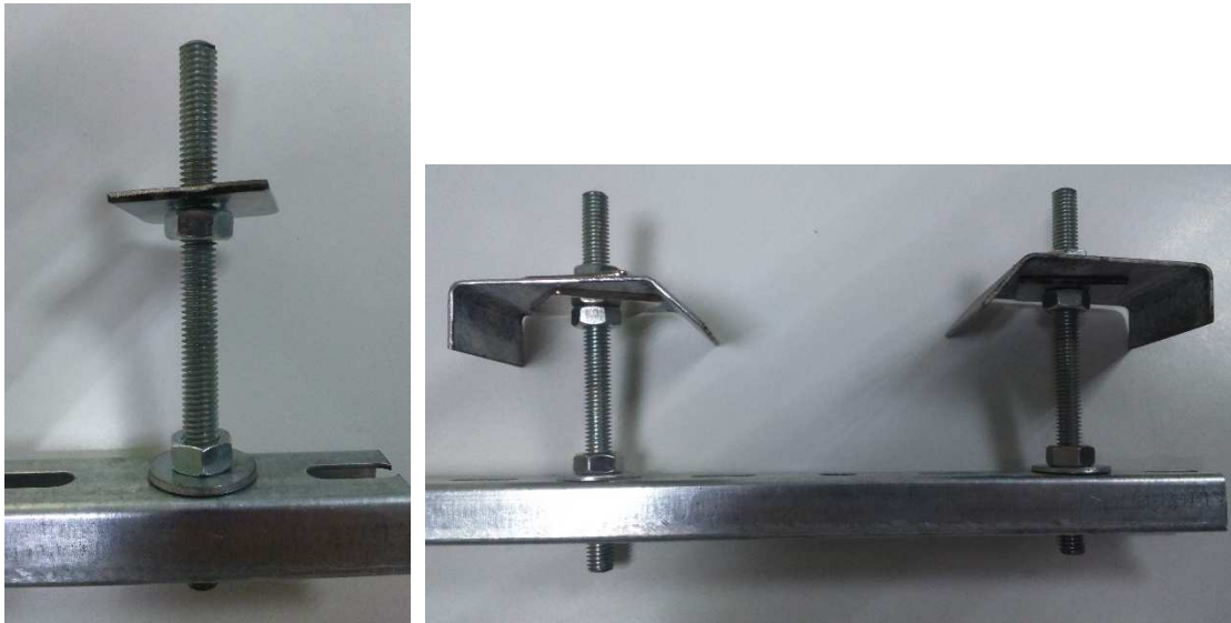
Imagen 63. Montaje del sistema de sujeción.
