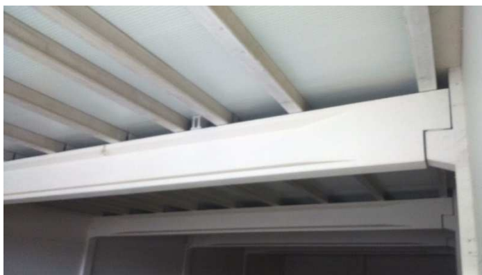
Imagen 29. Cubierta de nave industrial a estudio.
