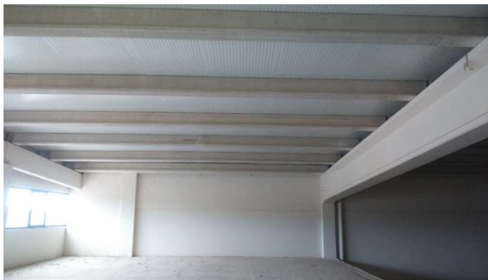
Imagen 28. Cubierta de nave industrial a estudio.
