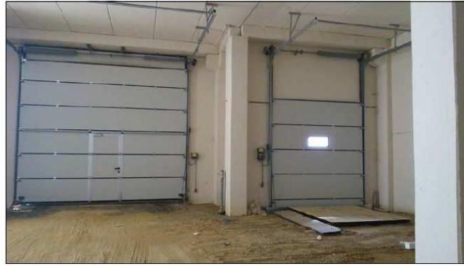
Imagen 11. Puertas de acceso rodado y muelle de carga de la nave del proyecto.
