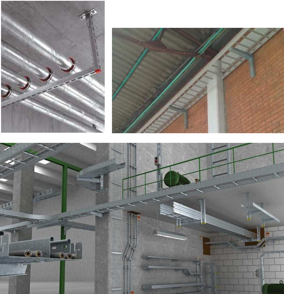
Imagen 32. Diferentes sujeciones de las instalaciones.
