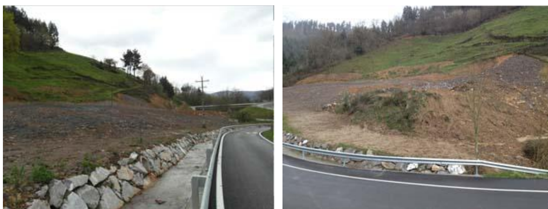
Figura 3.19. Vista del extremo sur de la explanada (izda.) y del acopio de materiales en el extremo norte (dcha.) desde la carretera.
