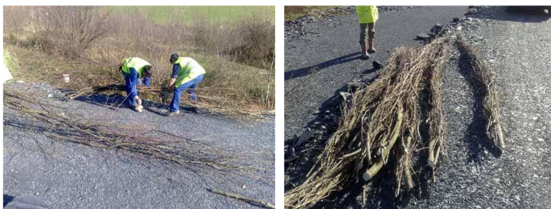
Figura 4.2. Proceso de confección (izda.) y obtención de fajinas vivas (dcha.) para construcción de drenajes. Fuente: UTE Buruntza, Andoain (Gipuzkoa), año 2010.
