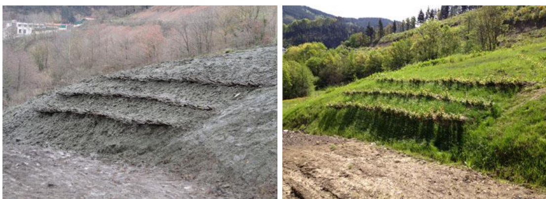
Figura 4.15. Aplicación inicial de hidromanta sobre superficie pendiente (izda.), y estado del terreno a los 3 meses (dcha.). Fuente: Integración paisajística de los taludes y estabilización bajo el viaducto Basagoiti de la AP-1 en Aretxabaleta, año 2012.
