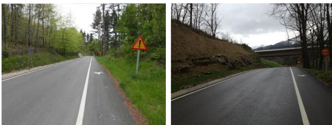
Figura 3.1. Carretera de acceso BI-4331 (izda.) y parte del desmonte norte que con el viaducto de Larrinagatxu al fondo (dcha).
