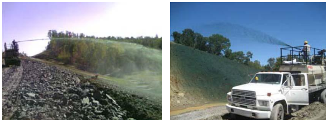
Figura 4.14. En los trabajos de hidrosiembra se requieren equipos de bombeo de 5-10 atmósferas para abarcar grandes superficies (izda.), y vehículos que accedan a todo tipo de terrenos (dcha.). Fuente: http://www.aquanea.com , año 2015.
