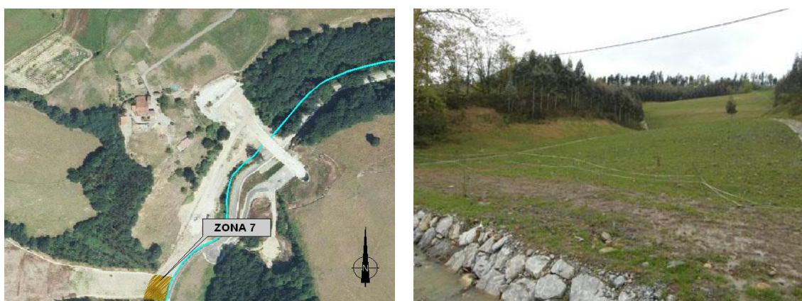
Figura 3.20. Localización de la Zona 7 en el plano (dcha.) e imagen del depósito de sobrantes desde la carretera.
