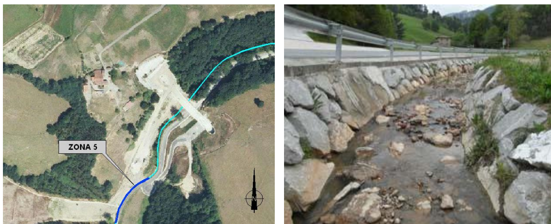
Figura 3.17. Localización de la Zona 5 en el plano (izda.) e imagen del tramo del arroyo con escollera desde el cauce (dcha.).
