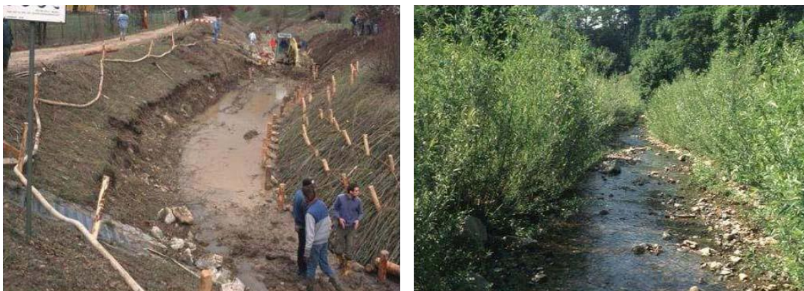
Figura 3.38. Aplicación de Bioingeniería (colchón de ramas) para estabilización y recuperación de márgenes de río, antes (izda.) y después (dcha). Fuente: Curso de Proyectos de Bioingeniería y Restauración Fluvial, 2013.
