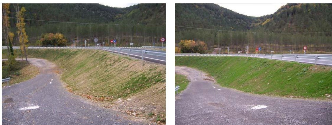
Figura 4.13. En una hidrosiembra ejecutada correctamente a principios de octubre, a los 15 días a asoma la cubierta herbácea (izda.) para acabar por asentarse al cabo del mes de noviembre (dcha.). Fuente: Trabajos de Hidrosiembra en carretera Arce Oroz-Betelu, Navarra, año 2005.
