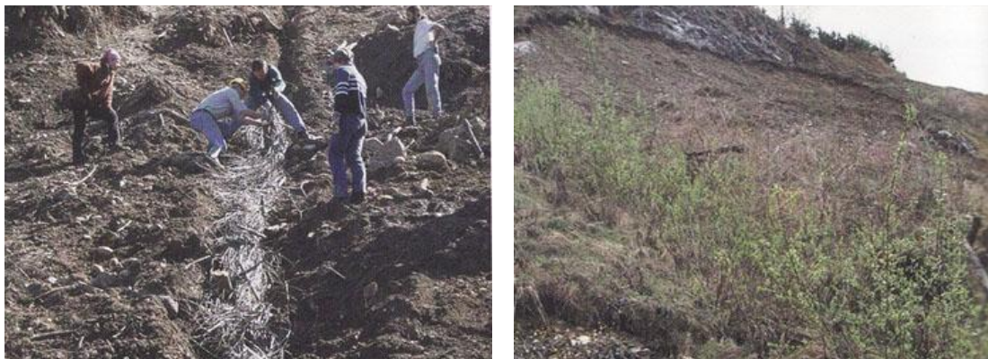
Figura 4.3. Excavación en ladera de zanja para posterior instalación de fajina drenante de sauce, (izda.) y estado transcurrido un período de 6 meses (dcha). Fuente: Ingeniería Biológica. Manual Técnico, año 2007.
