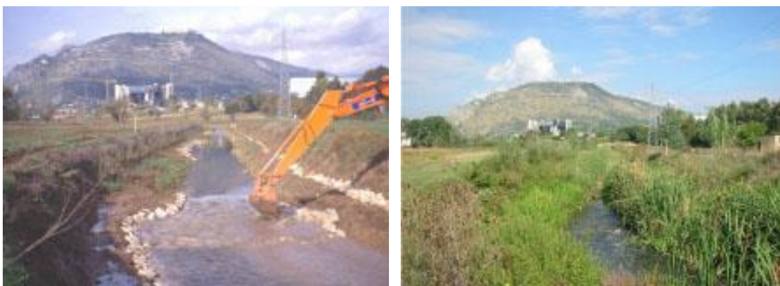
Figura 3.34. Mediante las actuaciones en las márgenes fluviales (izda.), se consigue aumentar la biodiversidad en los ríos y cursos de agua (dcha.). Fuente: Intervención en Río Fontanelle (FR), Foto Cornellini, P., 2001-2002.
