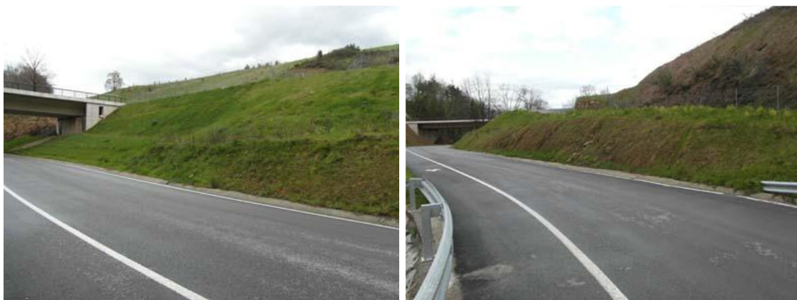
Figura 3.8. Extremo norte (izda.) y sur (dcha.) de relleno este.
