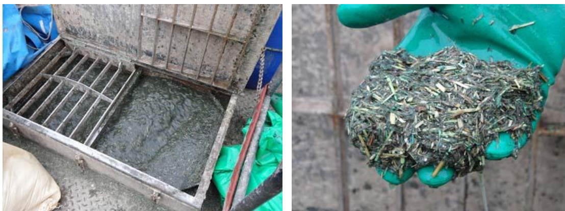
Figura 4.16. Proceso de mezcla de hidromanta en depósito de hidrosembradora (izda.) y muestra de de la mezcla final.producto final (dcha.). Fuente: Integración paisajística de los taludes y estabilización bajo el viaducto Basagoiti de la AP-1 en Aretxabaleta, año 2012.
