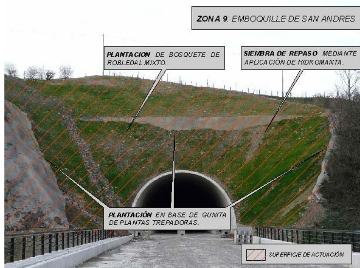
Figura 5.39. Imagen general de la Zona 9, donde se aprecian los trabajos de gunita de hormigón y las zonas donde no ha germinado todavía la cubierta herbácea.
