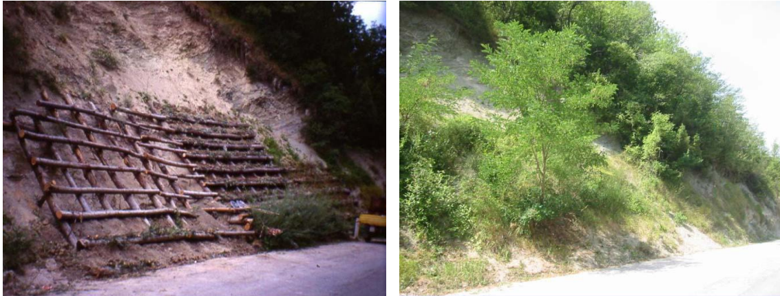
Figura 3.49. Obras de bioingeniería como el enrejado vivo presentan una gran persistencia, desde su instalación en 1997 (izda.) hasta pasados casi de 10 años, 2006 (dcha.). Fuente: Curso de Proyectos de Bioingeniería y Restauración Fluvial, año 2013.
