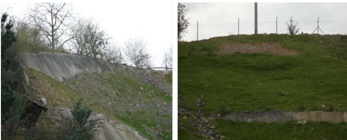
Figura 3.25. Gunitado en el extremo sur superior del emboquille (izda), y terreno desprendido en su parte superior (dcha).
