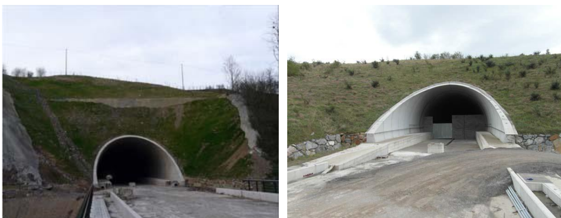
Figura 3.4. Vista de emboquille de San Andrés, (izda.), y emboquille de Mendigain (dcha.), desde el viaducto.
