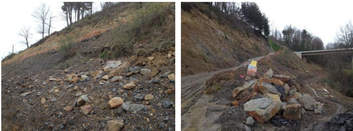
Figura 3.14. Sobre la ladera de la margen izquierda se observan rocas y pedrascos de gran tamaño, y varios matorrales de Buddleia (izda.) y en el extremo sur de la ladera confluyen el camino sobre la ladera y la berma sobre la orilla (dcha.).
