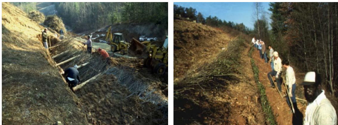
Figura 3.45. La mejor época para realizar obras como el entramado (izda.) o las fajinas vivas (dcha.) siempre será el de parada vegetativa. Fuente: Engineering Field Handbook. Chapter 18. Soil Bioengineering for Upland Slope Protection and Erosion Reduction, año 1992.
