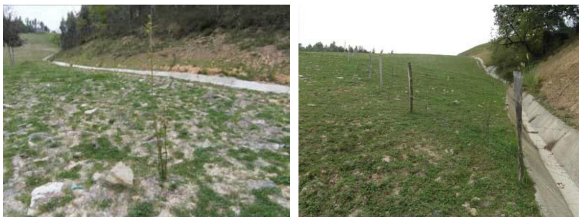
Figura 3.21. Arbusto dañado por ganado (izda.) y vallado construido en el extremo sudeste del depósito de sobrantes (dcha.).
