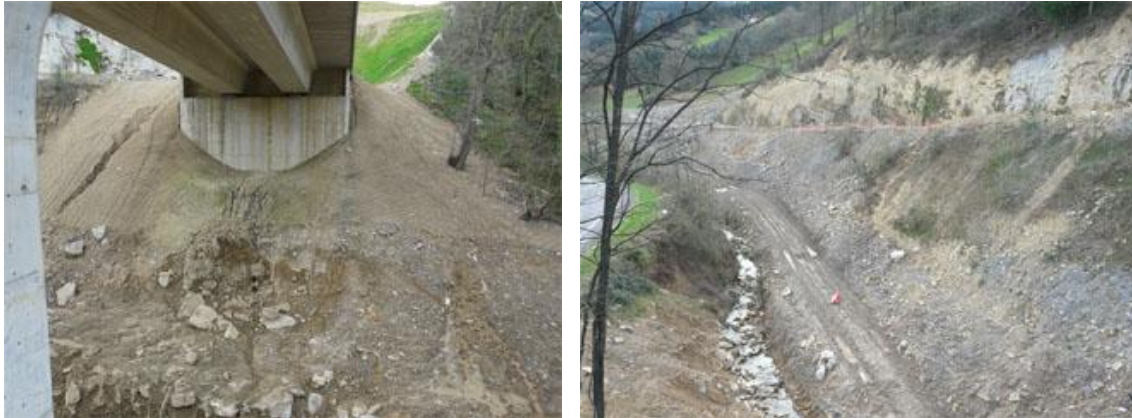
Figura 3.13. Entorno del viaducto de la margen izquierda (izda.) y desprendimientos de la orilla de la margen izquierda (dcha.).
