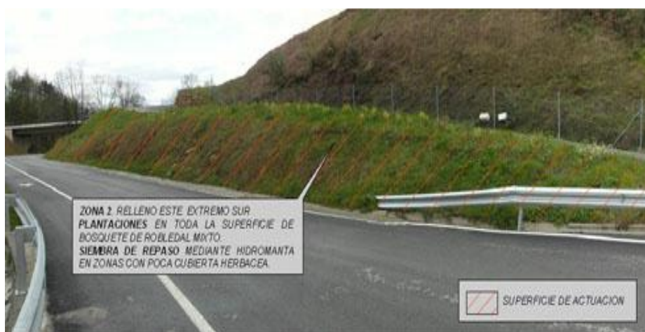
Figura 5.14. Zona 2, según se avanza hacia el sur, la altura del relleno va decreciendo, y la ausencia de cubierta herbácea es más evidente.
