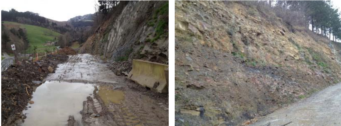
Figura 3.15. Inicio del camino sobre la ladera, con parte del desmote oeste gunitado (izda.) y zona final del camino, donde sobre el desmote van aflorando sustratos de roca (dcha.).
