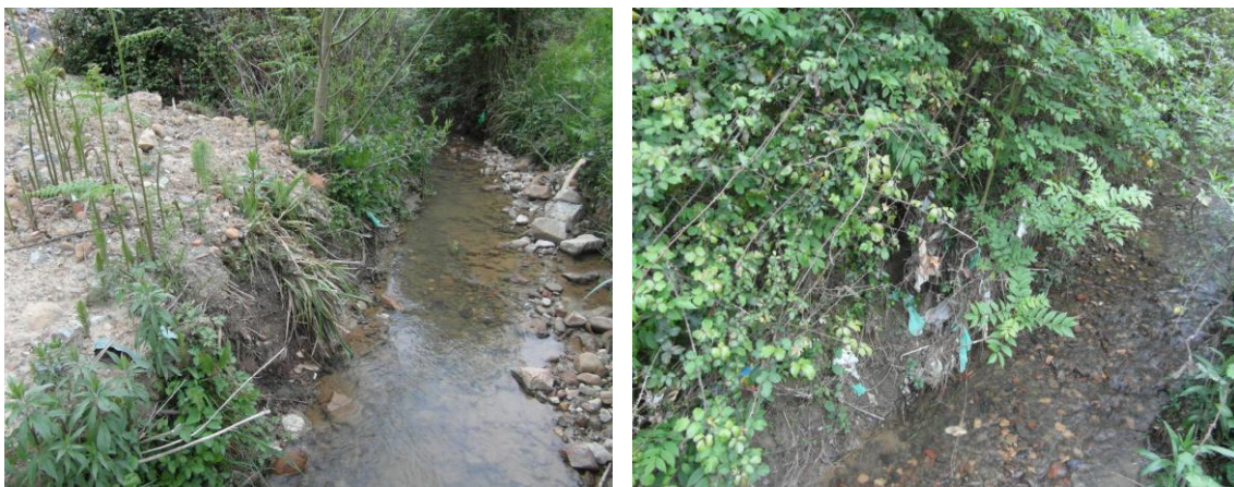
Figura 3.16. Zona con vegetación de la margen izquierda, donde se aprecian pequeños desprendimientos de la orilla (izda.y dcha).
