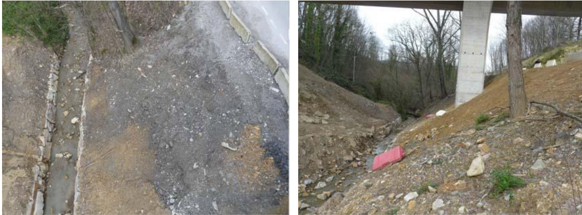
Figura 3.10. Vista de la ladera norte desde el viaducto (izda.) y sur (dcha.) desde la orilla de ladera de la margen derecha.
