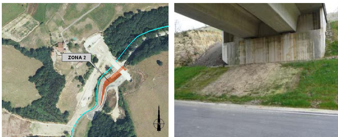
Figura 3.7. Localización de la ZONA 2 en el plano (izda.), y zona del estribo bajo el viaducto (dcha).
