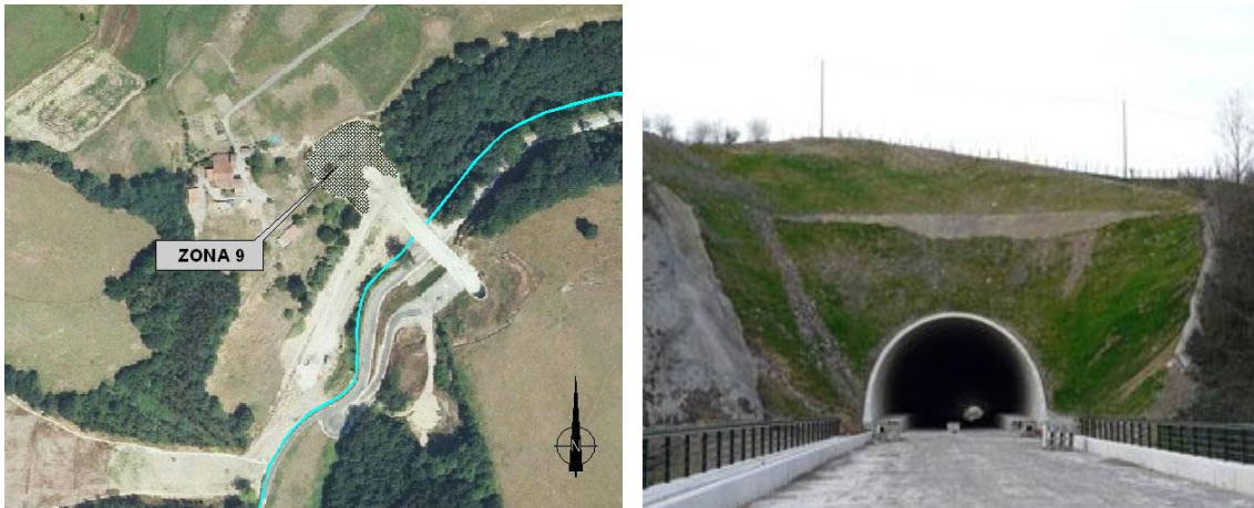
Figura 3.24. Localización en el plano de la Zona 9 (izda.), y vista general del emboquille (dcha.).
