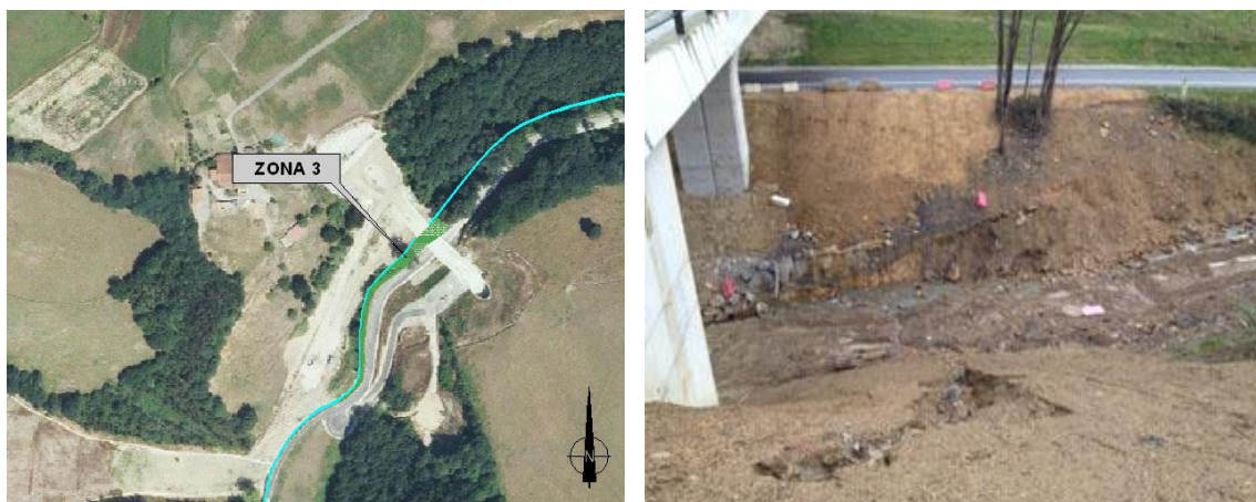
Figura 3.9. Localización de la Zona 3 en el plano (izda.) y zona con desprendimientos sobre el cauce del arroyo (dcha.).
