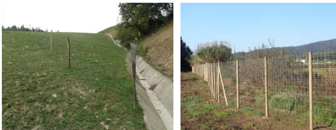
Figura 5.37. Cierre ganadero instalado en parte superior del depósito de sobrantes (izda.), y muestra del que se construirá en la plataforma inferior (dcha.).
