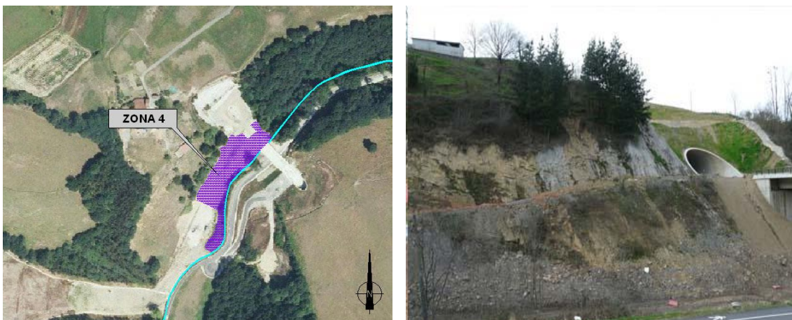
Figura 3.12. Situación en plano de la Zona 4 (izda.) y vista de la ladera de la margen izquierda y el desmonte oeste desde la carretera (dcha.).
