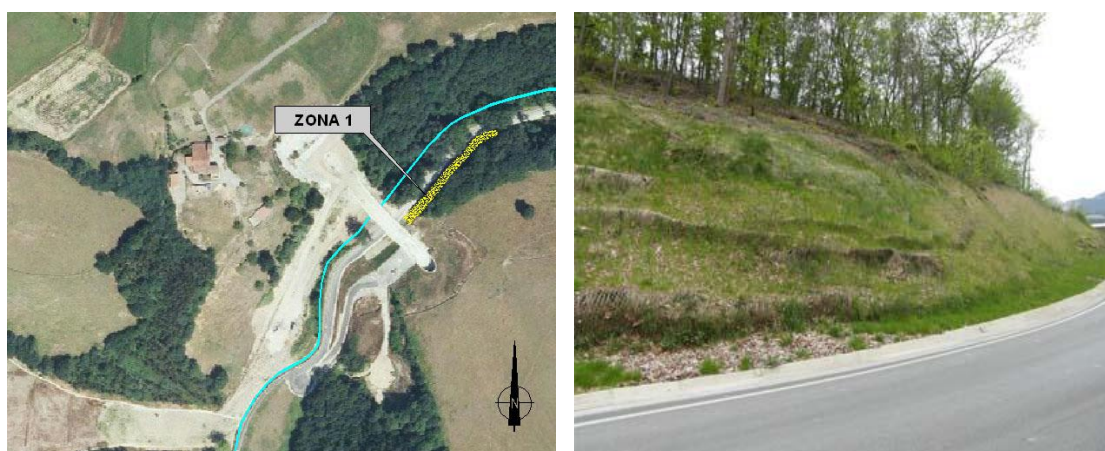
Figura 3.6. Localización de la ZONA 1 en el plano (izda.), e imagen del desmonte con malla galvanizada y sin malla (dcha.).
