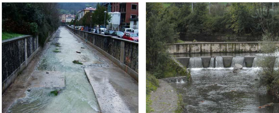
Figura 3.28. El desarrollo urbano ha provocado la proliferación de rectificaciones del cauce de los ríos, como el río Kilimoi (izda.) en Mendaro (Gipuzkoa) y construcciones como presas y azudes en el río Ibaizabal (dcha.) en Amorebieta (Bizkaia), año 2014.
