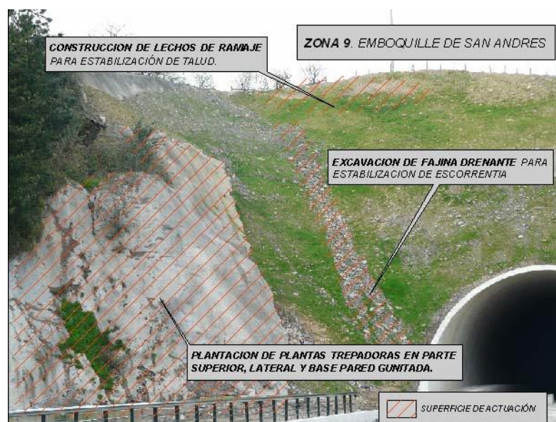
Figura 5.41. Imagen ampliada de la cara sur de la Zona 9, donde se puede apreciar el desprendimiento del talud en la parte superior, la escorrentía y el muro gunitado de hormigón.
