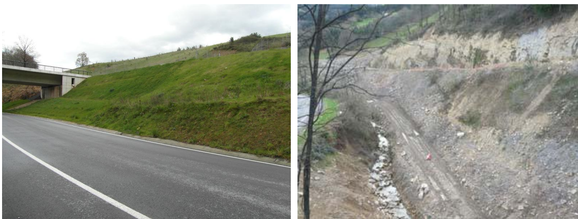
Figura 3.2. Vista desde la carretera del estribo y relleno este (izda.), y zona del arroyo con desprendimientos en ambas márgenes desde el viaducto (dcha.).
