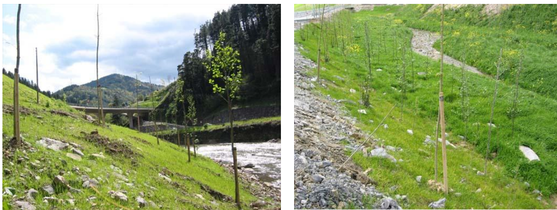
Figura 4.18. Trabajos de revegetación de los ríos Deba en Elgoibar (izda.) y Arroa en Zestoa (dcha.) en Gipuzkoa en el año 2004, la presencia del Aliso en primera línea de cauce es siempre indispensable.
