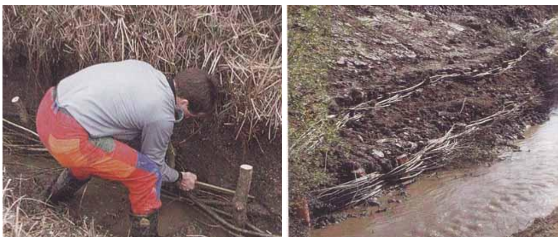
Figura 4.4. El trenzado es un trabajo que puede desempeñar uno dos operarios (izda.), estabilizando pequeños desprendimientos en las márgenes (dcha.). Fuente: Ingeniería Biológica. Manual Técnico, año 2007.
