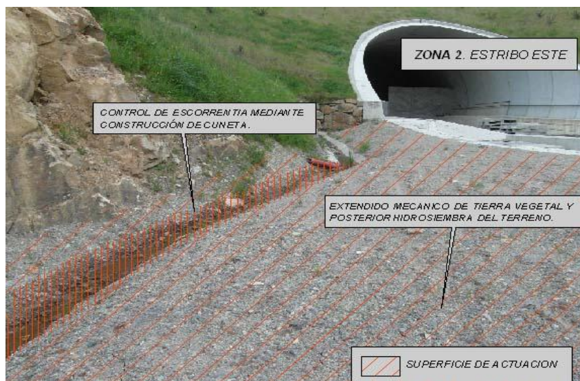
Figura 5.13. Zona 2, terreno junto al emboquille de Mendigain, donde se encauzará la bajante de aguas, se añadirá tierra vegetal y sembrará el terreno.
