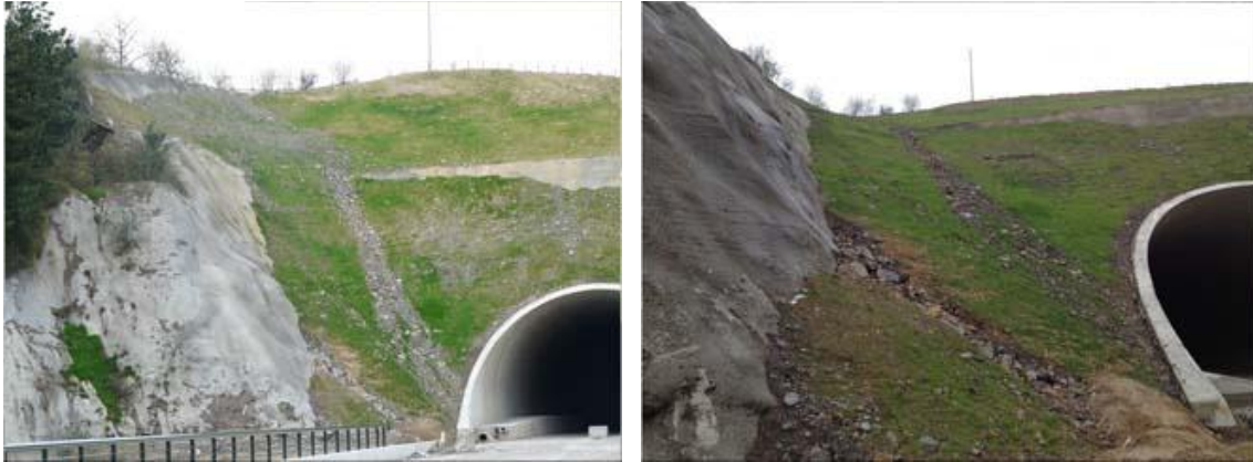
Figura 3.26. Vista del muro gunitado al sur del emboquille (izda.), y detalle de la escorrentía (dcha.).
