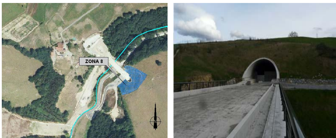
Figura 3.22. Localización en plano de la Zona 8 (izda.), y vista del emboquille desde el viaducto (dcha.).
