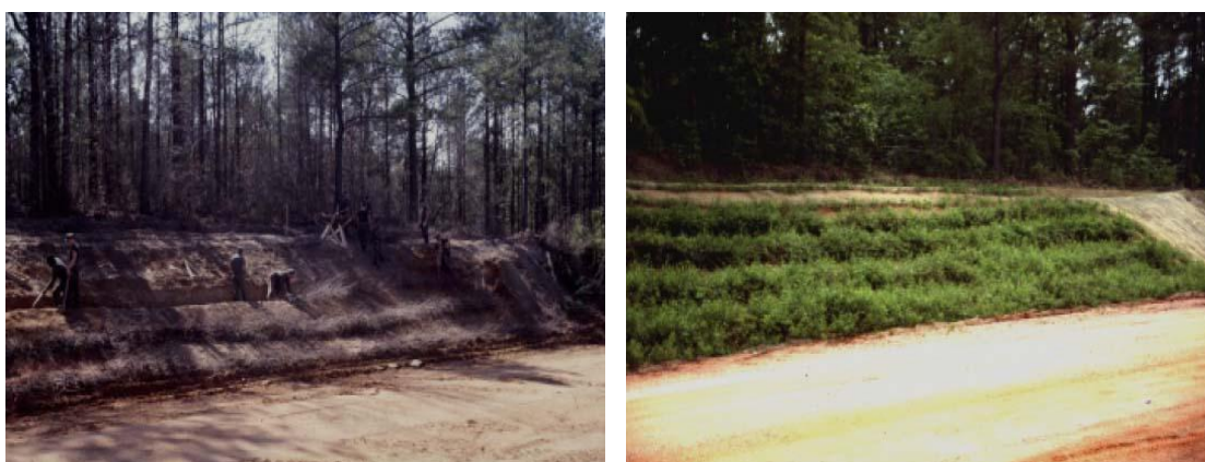
Figura 4.10. Proceso de construcción de lechos de ramaje, sistema de 4 peldaños (izda.) y estado 2 años después (dcha.). Fuente: Engineering Field Handbook. Chapter 18. Soil Bioengineering for Upland Slope Protection and Erosion Reduction, año 1992.
