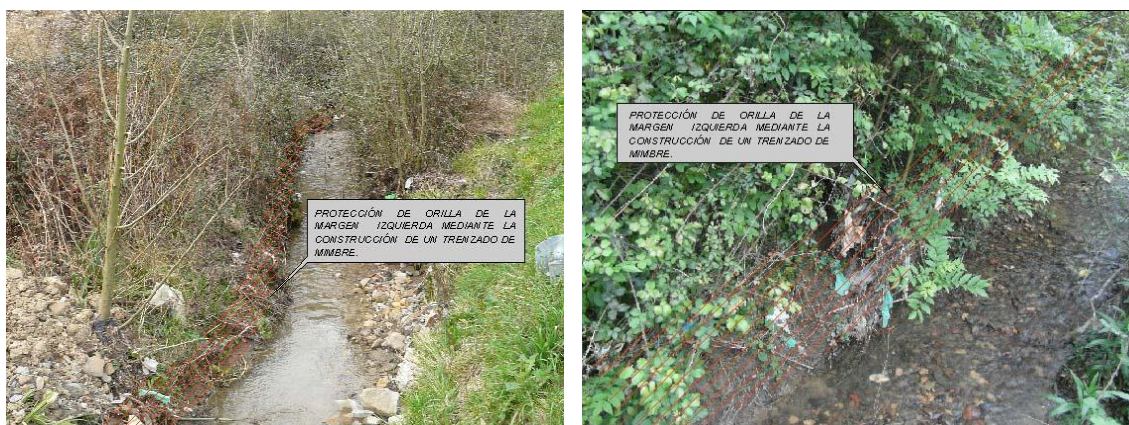
Figura 5.32. Imágenes de la orilla de la margen izquierda en la Zona 4, (izda. y dcha.) donde se tiene previsto construir un trenzado de ribera.
