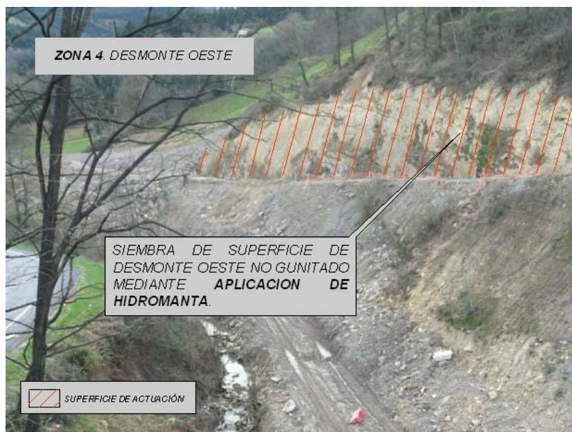
Figura 5.28. Zona 4, tramo del Desmonte Oeste sobre la que se tiene previsto aplicar una hidromanta.
