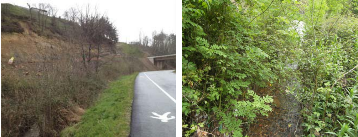
Figura 3.11. Vista en carretera de la margen derecha (izda.) y desde el propio cauce del arroyo.
