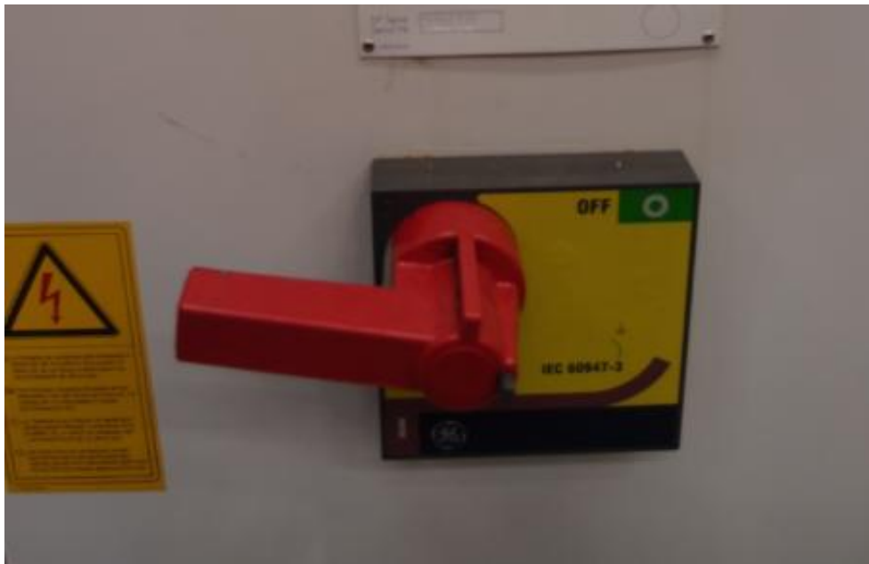
Figura 8.3.1 Seccionador en la puerta del armario
