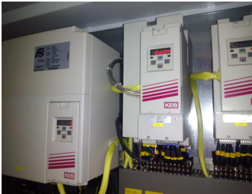
Figura 7.2 Detalle de variadores de frecuencia instalados en un armario
