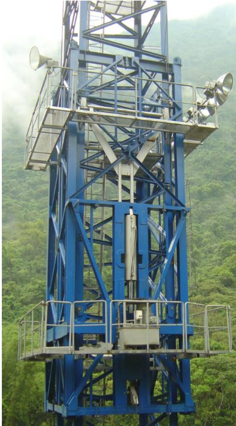
Figura 4.3.11 Jaula de trepado instalada en la torre
