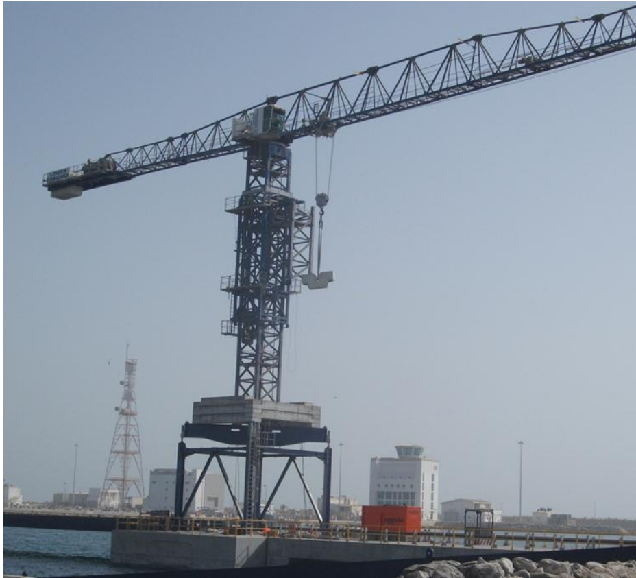
Figura 4.3.1.4.1 Grúa instalada sobre base en cruz y sobre portal
