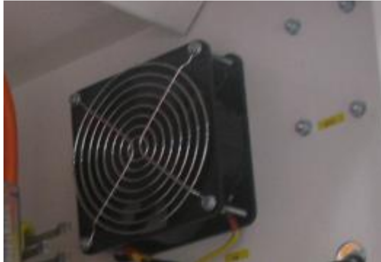
Figura 8.3.2 Ventilador en el interior del armario eléctrico
