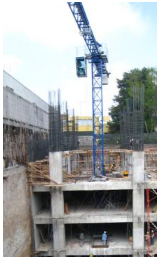
Figura 4.3.13.2 Grúa trepadora dentro del edificio
