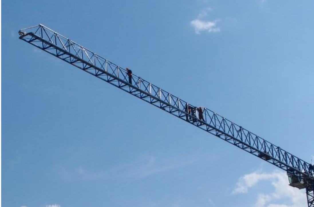
Figura 4.3.6 Pluma de la grúa durante ensamblaje
