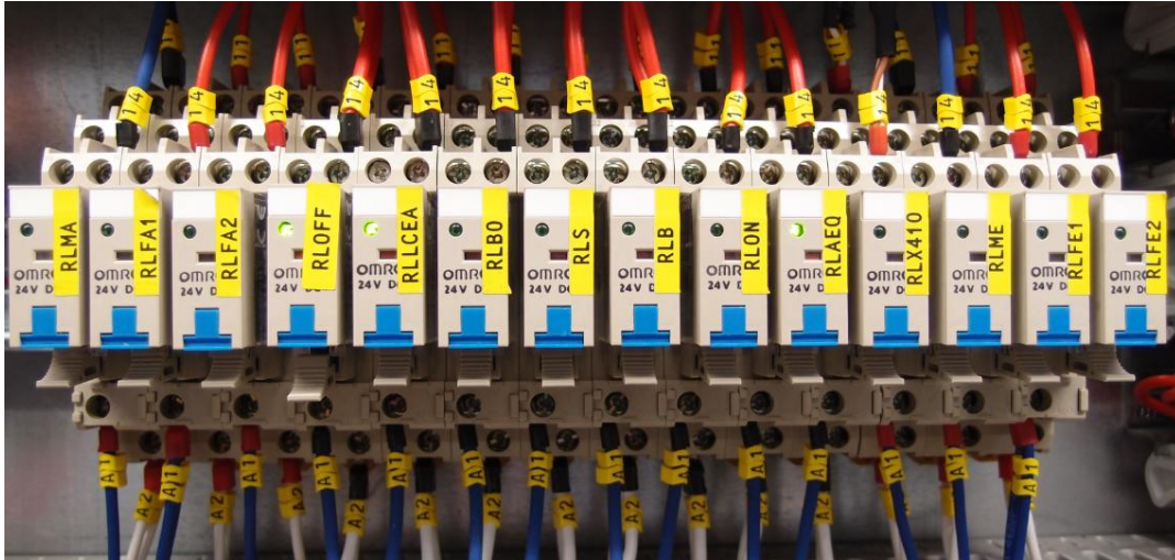
Figura 8.5 detalle de relés auxiliares
