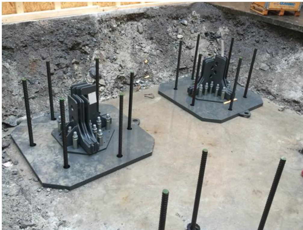
Figura 4.3.1.3.2 Detalle de colocación de los pies recuperables
