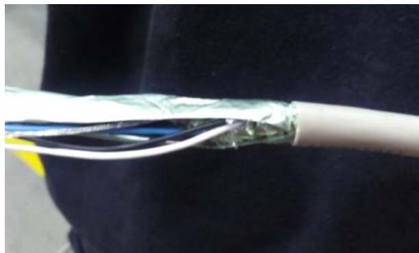
Figura 8.4.4.2.1 Detalle cable encoder y apantallamiento
