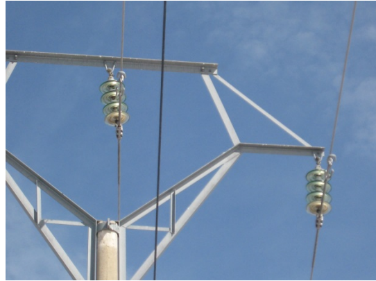
Apoyo en alineación con aislamiento suspendido, precedido de un apoyo con aislamiento en amarre a tresbolillo.
