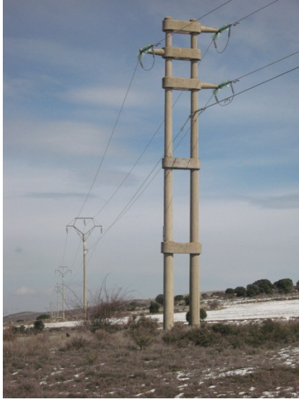
Apoyo en alineación con aislamiento suspendido, precedido de un apoyo con aislamiento en amarre a tresbolillo.
