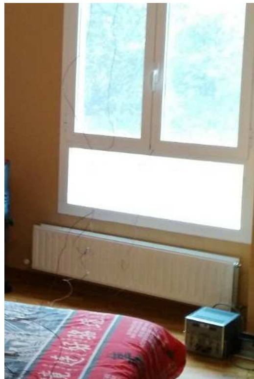
Figura 78. Radiador de calefacción convencional para el modelo de pruebas B
