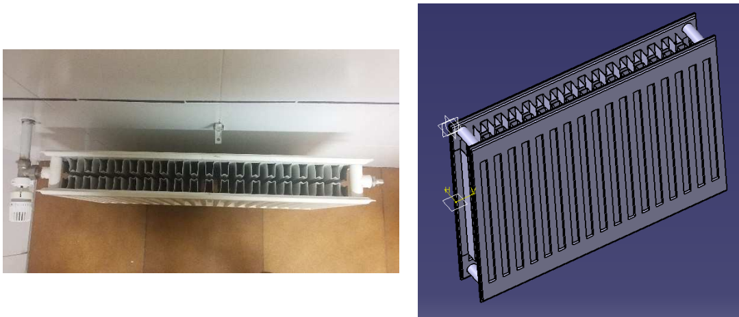
Figura 24. Radiador PCCP 450 real (izq.) y en CATIA (dcha.)
