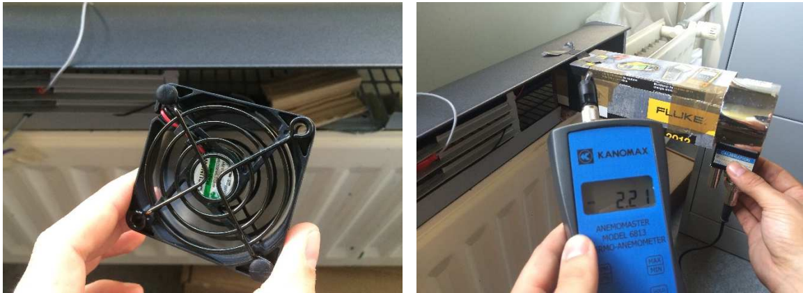
Figura 53. Ventilador de 60 con protección circular; frontal (izq.) y colocado en el DAREC (dcha.)
