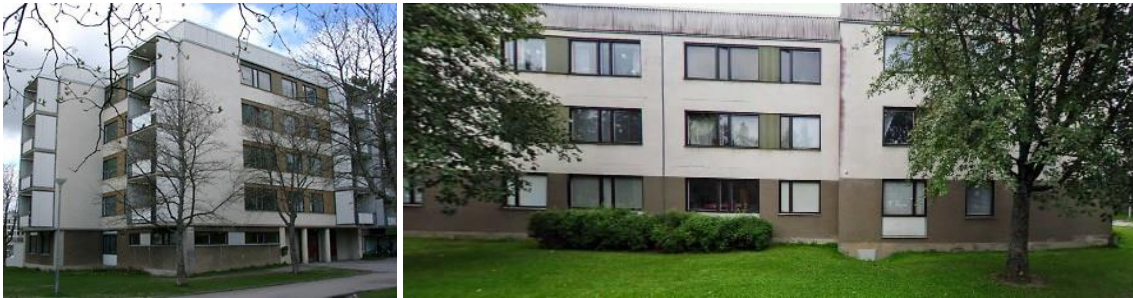
Figure 7: Buildings Sättra 1 and Sättra 2, respectively
