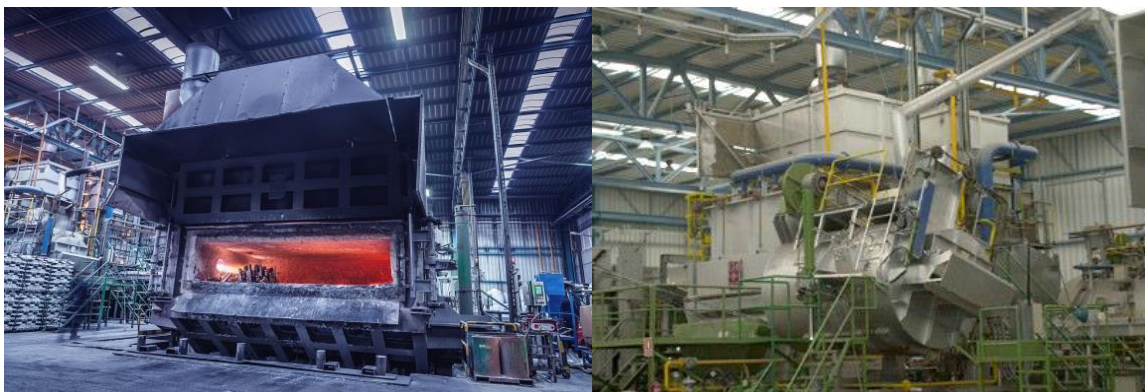
Figura 6. Horno reverbero (a la izquierda) y torre fusora (a la derecha).
