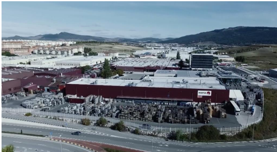
Figura 1. Vista de la planta de Mapsa en Orkoien.
