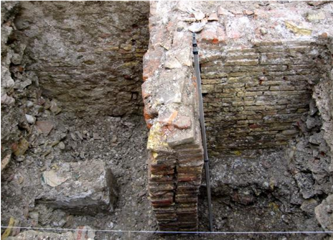
Vista general del muro de ladrillo correspondiente a la bodega. Fuente: Mikel Ramos.
