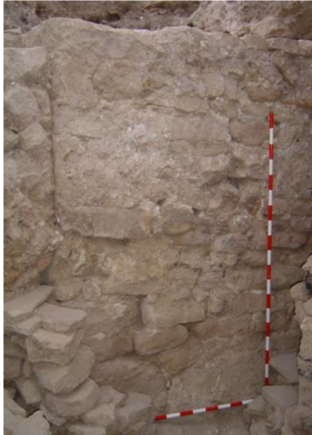
Reparación del muro de la torre. Fuente: Mikel Ramos.
