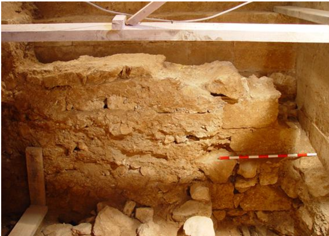
Muro correspondiente al área de la cata N°3 (s. XII). Fuente: Mikel Ramos.
