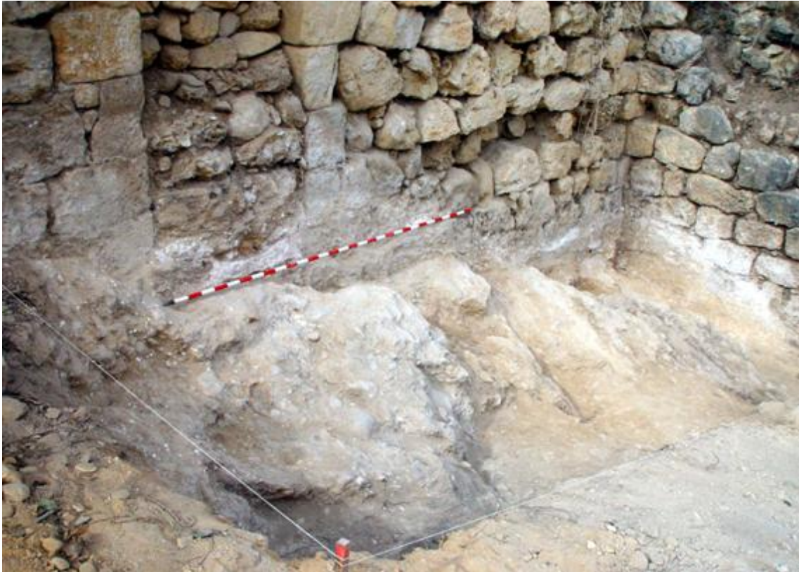
Detalle de la excavación de la puerta tapiada y su cimentación. Fuente: Mikel Ramos.
