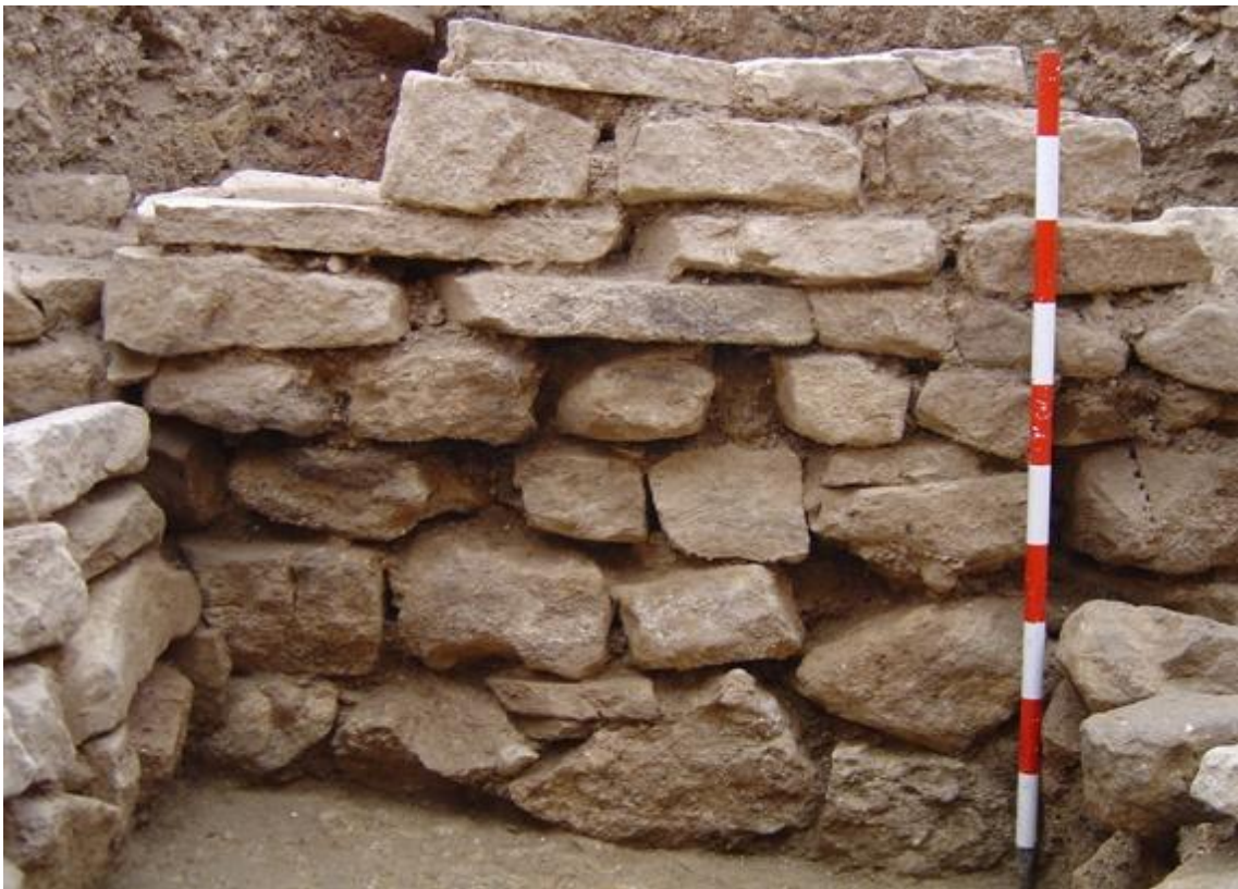
Muro adosado a la torre. Fuente: Mikel Ramos.
