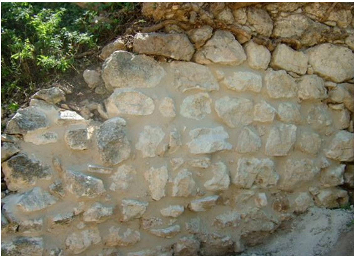
Labores de consolidación del muro oeste. Fuente: Mikel Ramos.
