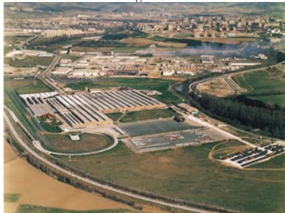
Figura 4. Vista de la fábrica en la etapa Seat.
