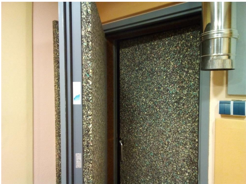
Figura 26. Puerta doble construida con paneles aislantes.
