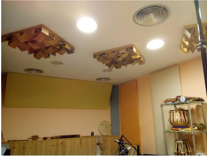
Figura 27. Paneles absorbentes móviles y difusores fijos presentes en la sala de ensayo.
