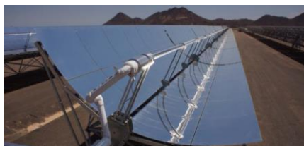
Figura 9: Detalle de un espejo cilindro-parabólico [ABENGOA SOLAR]
