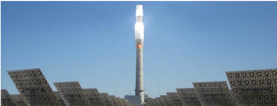
Figura 25: Detalle de una torre de Gemasolar [Torresol Energy]
