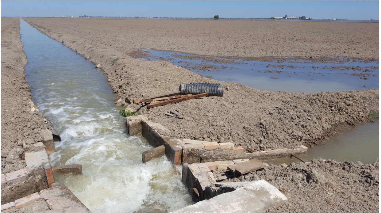
Piqueras de riego antes de proceder a la inundación de las tablas
