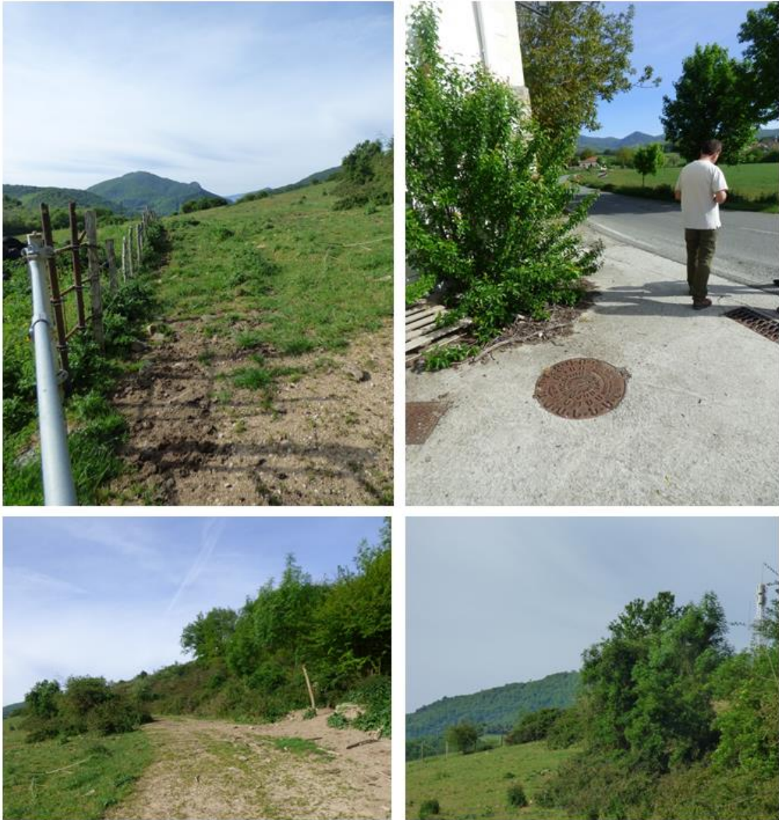
Figura 71: Tramo de fibra en Udabe.
