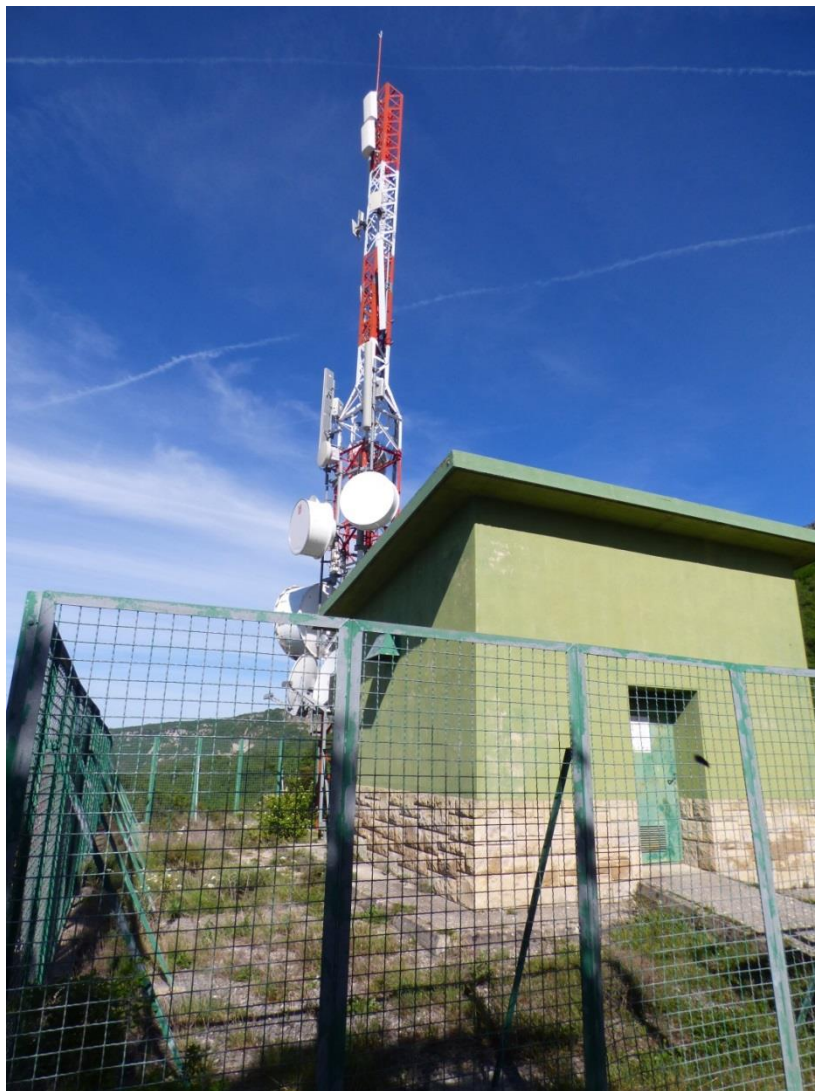
Figura 28: Ejemplo centro de telecomunicaciones (CT Desojo).
