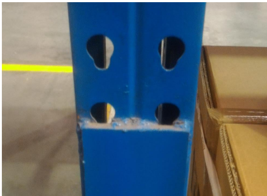
Ilustración 22. Bastidor con soldadura.
