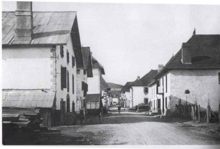
Figura 17. Calle principal, con los canales sin construir, 1915. (Irigaray, 2016)
