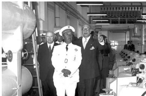
El “Caudillo” en la inauguración de una fábrica de Pebsa. A Coruña, año 1960.
