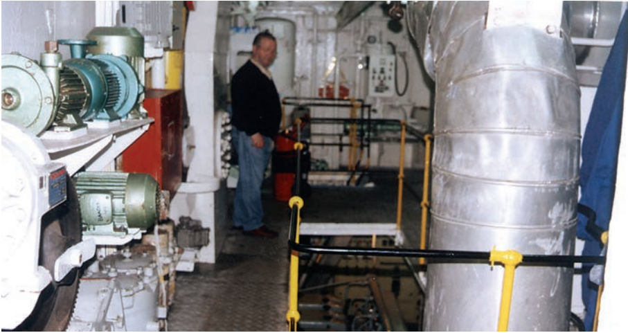
Sala de máquinas del “Nuevo Virgen de la Barca” “Nuevo Virgen de Lodairo”
