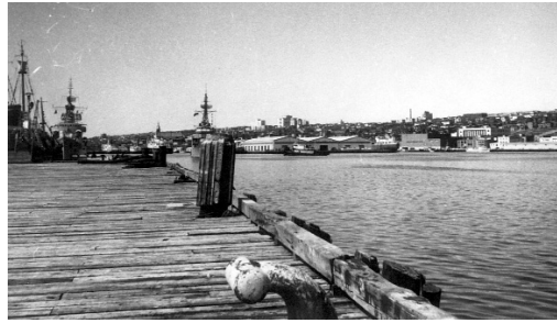
Muelle Sur, de madera, del puerto de St. John's.
