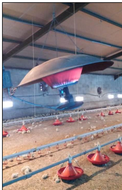
Figura 8. Calentador por radiación en una granja de pollos del Grupo AN.
