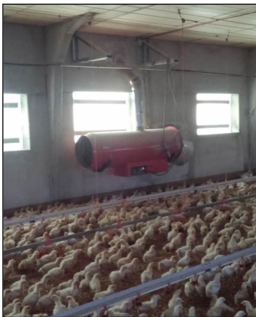
Figura 7. Calentador de ambiente en una granja de pollos del Grupo AN.
