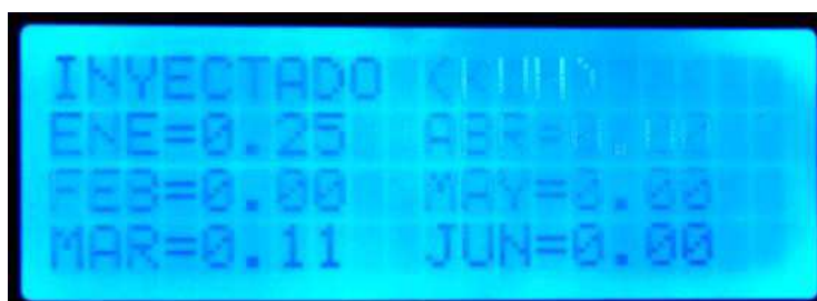
Figura 148: Pantalla de totalizador de inyección energética
