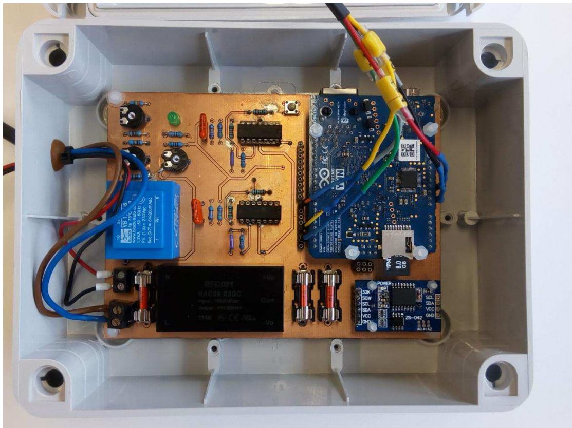
Figura 139: PCB montada en la caja de registro
