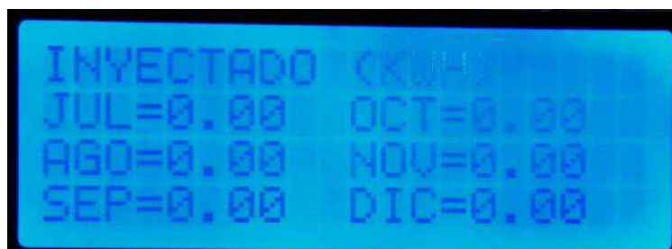
Figura 149: Pantalla de totalizador de inyección energética
