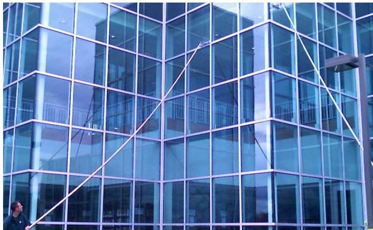
Fig.3.1. Limpieza de edificio mediante pértigas(Aragón).
