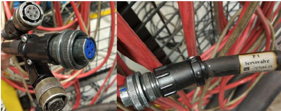
Figura 2.51: Conexiones de los cables de control para los actuadores
