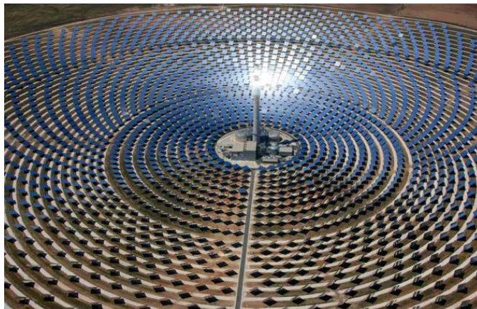
Figura 13: Tecnología de Torre (Gemasolar)
