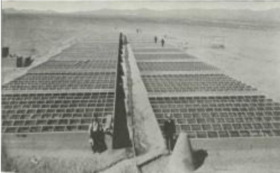
Figura 8: Primera planta desaladora solar del mundo, diseñada por Charles Wilson (Chile, 1872)
