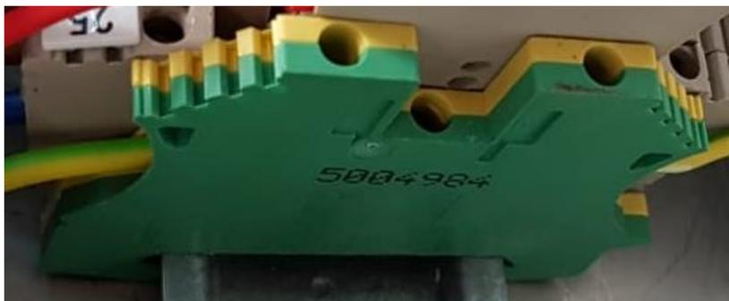
*Ilustración 33: Borne de toma tierra sobre carril DIN.*
