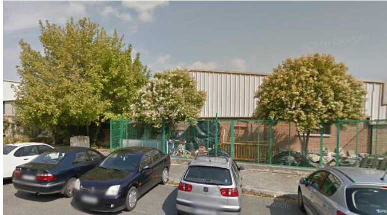
Ilustración 20. Fachada correspondiente a la calle F
