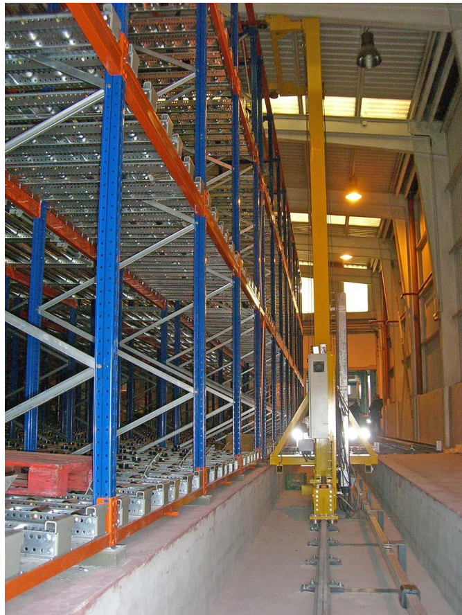
Fig. 51 Almacén automático con transelevador. [7].
