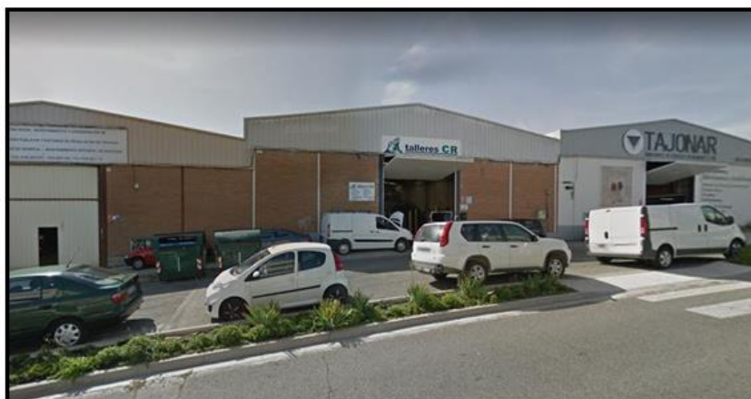
Figura 2. Zona delantera de la nave, calle E
