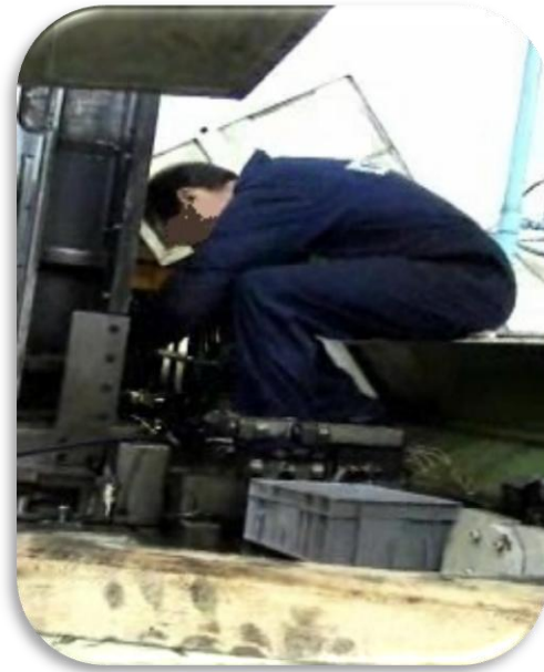
Foto: operario sentado en altura desatornillando
