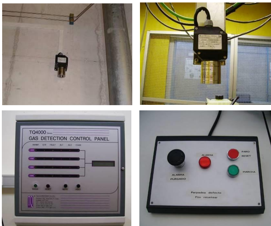
Fig.14 Sensores de combustible (arriba), panel y mando de control (abajo)
