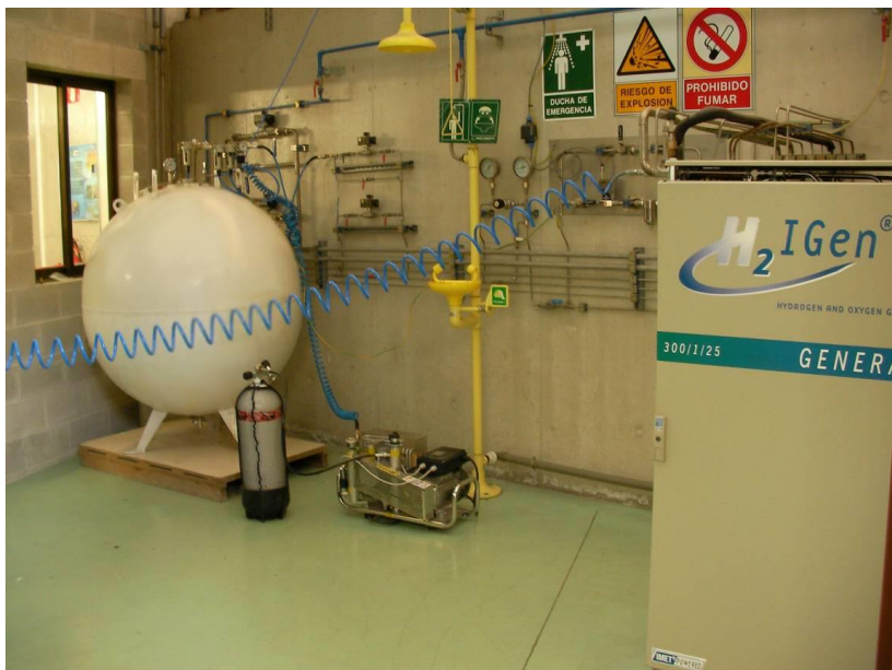
Fig.4 Electrolizador
