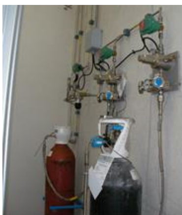
Fig.12 Instalación de gases fuera de la celda
