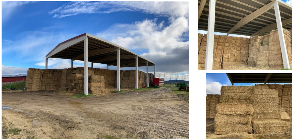
Ilustración 6. Almacén paja y forraje ( Pajera). Elaboración propia.
