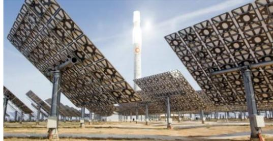
Figura 34: Heliostato con su superficie reflectante, estructura metálica y sistema de seguimiento solar
