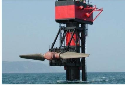
Figura 8: SeaGen 1,2 MW, Estrecho de Strangford
