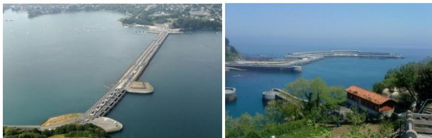
Figura 7: Central mareomotriz Rance Tidal 240MW Bretaña (izquierda), Central undimotriz Motrico 296kW Guipúzcoa (derecha)
